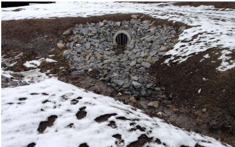
Figur 17: Befintlig ledning som släpper ut dagvatten i dike på förskolan.
