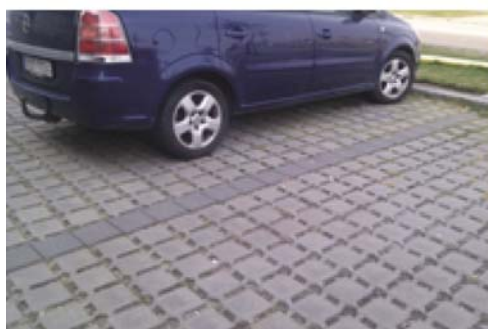
Ovan till vänster och höger: Dagvattenrännor (foto: Carina Lindberg). Nedan t.v. Genomsläppligt markmaterial ( foto: Nicklas Johansson.) Nedan t.h. Regnträdgård (foto: Sweco).
