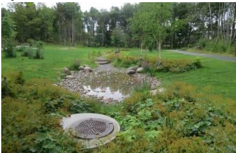
Figur 7:1 Exempel på ett dike med möjlighet till att omhänderta och fördröja större flöden.
