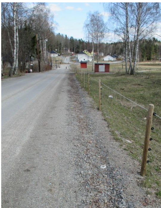
Figur 7:4 Exempel på hur Huddinge kommun anlagt svackdiken för vägdagvatten längs högra sidan av Blåsvägen. Foto: Sara Jansson 201-04-02.
