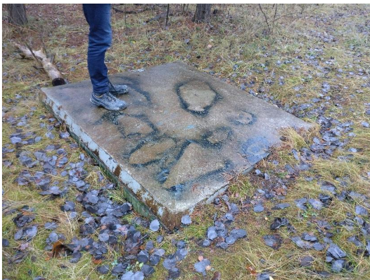
Figur 3 En lucka med okänt syfte upptäcktes vid platsbesök
