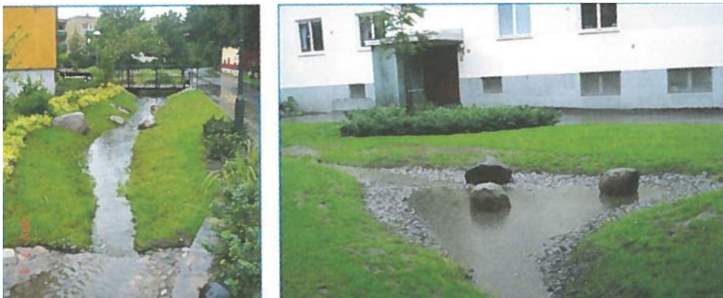
Bild 2. Öppna avvattningsstråk med vattenspegel (Figur 9.27 i P105).
