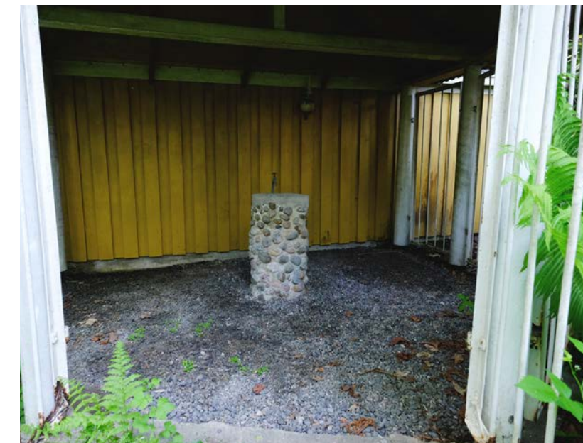
Kioskbyggnaden invändigt, med dryckesbrunn.
