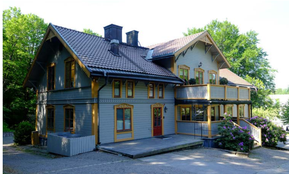
Brunnshuset (P), norra fasaden och östra gaveln.
