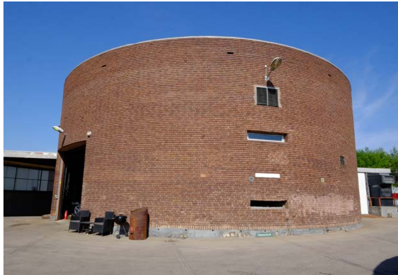
Panncentralen (A), med nedfart till underjordiska utrymmen till vänster. Vy från sydöst.
