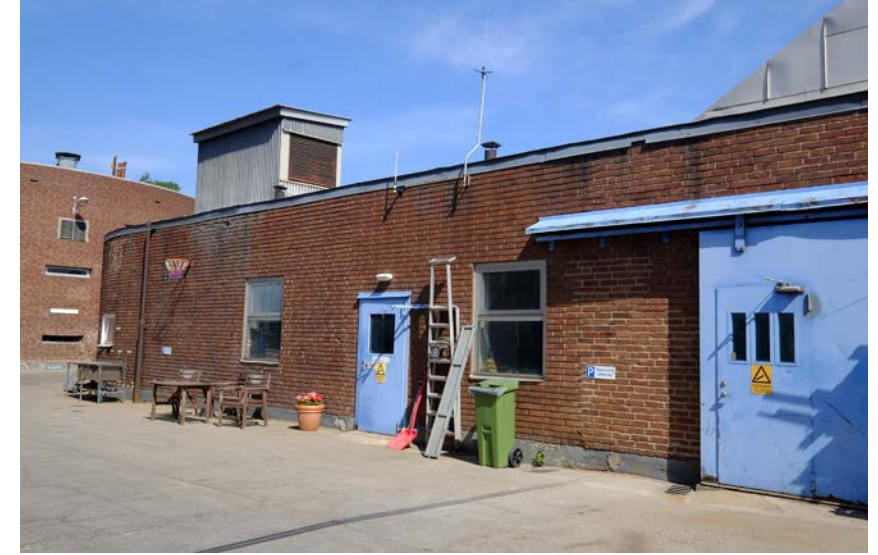
Verkstadsbyggnaden (K), västra delen av södra fasaden.
