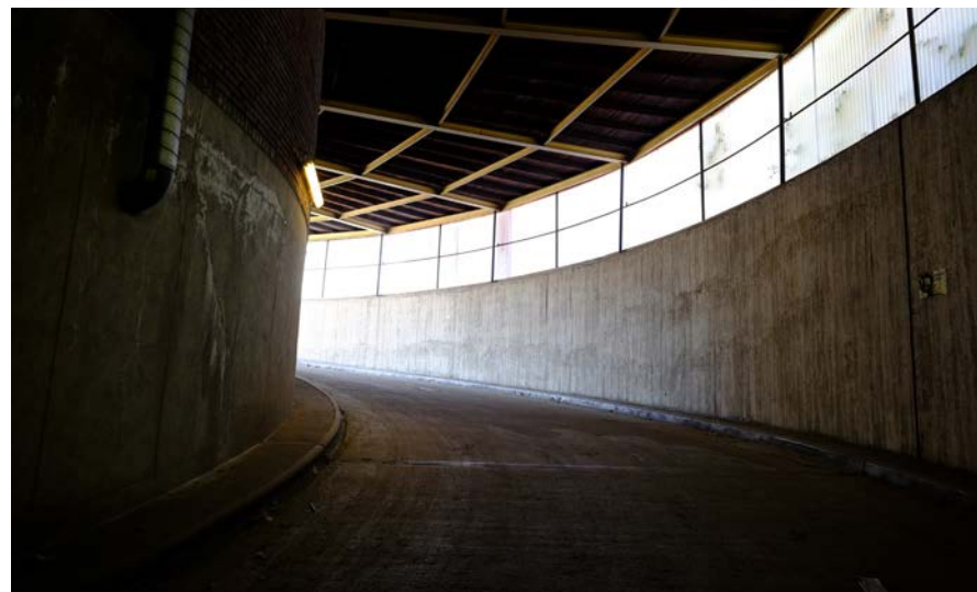
Nedfartsrampen vid panncentralen till utrymmen under mark.
