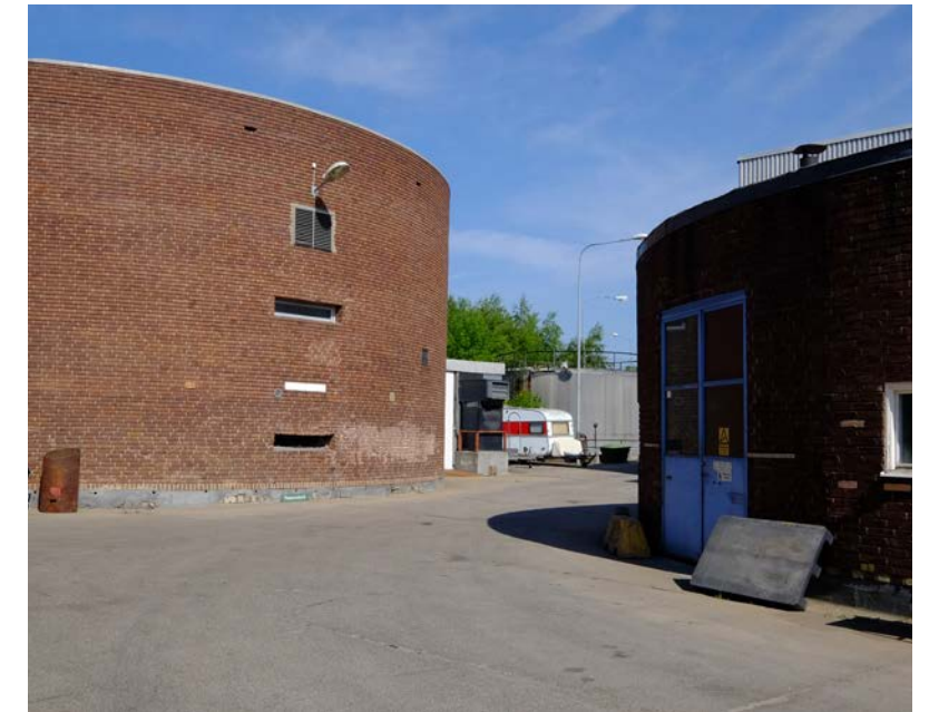
26. Panncentralen till vänster och verkstadsbyggnaden till höger, från sydöst 2018. På panncentralens östra sida har ytterligare fönster och ventilationsgaller tillkommit ovanför det ursprungliga, nedersta fönstret. Port och fönster på verkstadsbyggnaden är också senare tillkomna.
