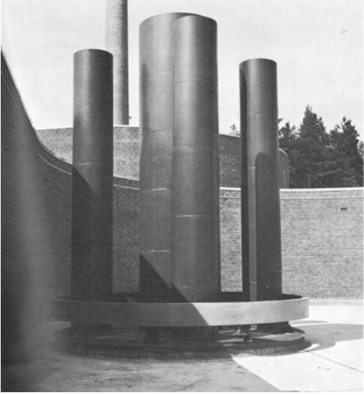
22. Verkstadsbyggnadens norra innergård med ventilationstorn i form av stålrör 1965. I bakgrunden panncentralen med ursprunglig skorsten i tegel.
