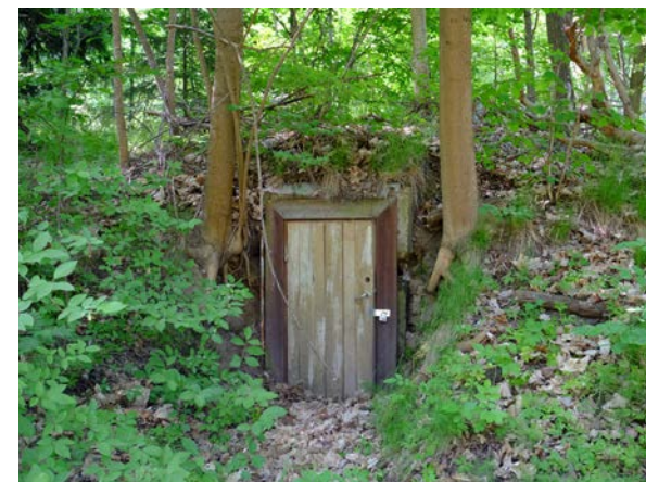
Jordkällare vid trädgårdsmästarebostaden.
