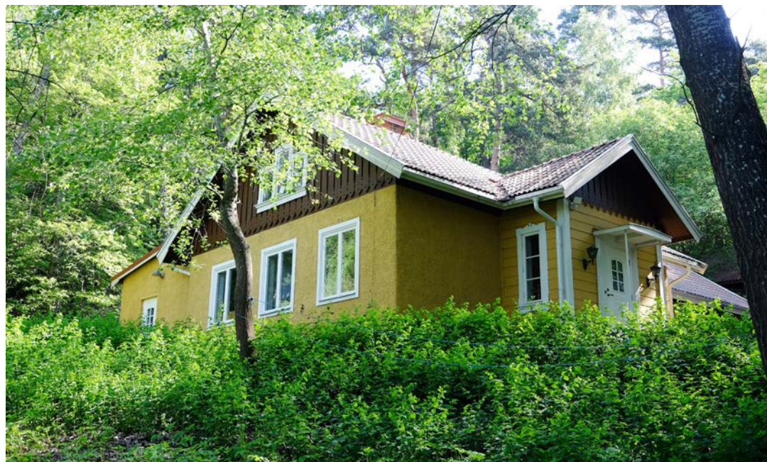
Trädgårdsmästarebostaden (Q). Västra gaveln och södra fasaden.
