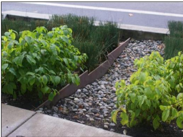
Figur 10. Exempel mindre dämmen i regnbädd
