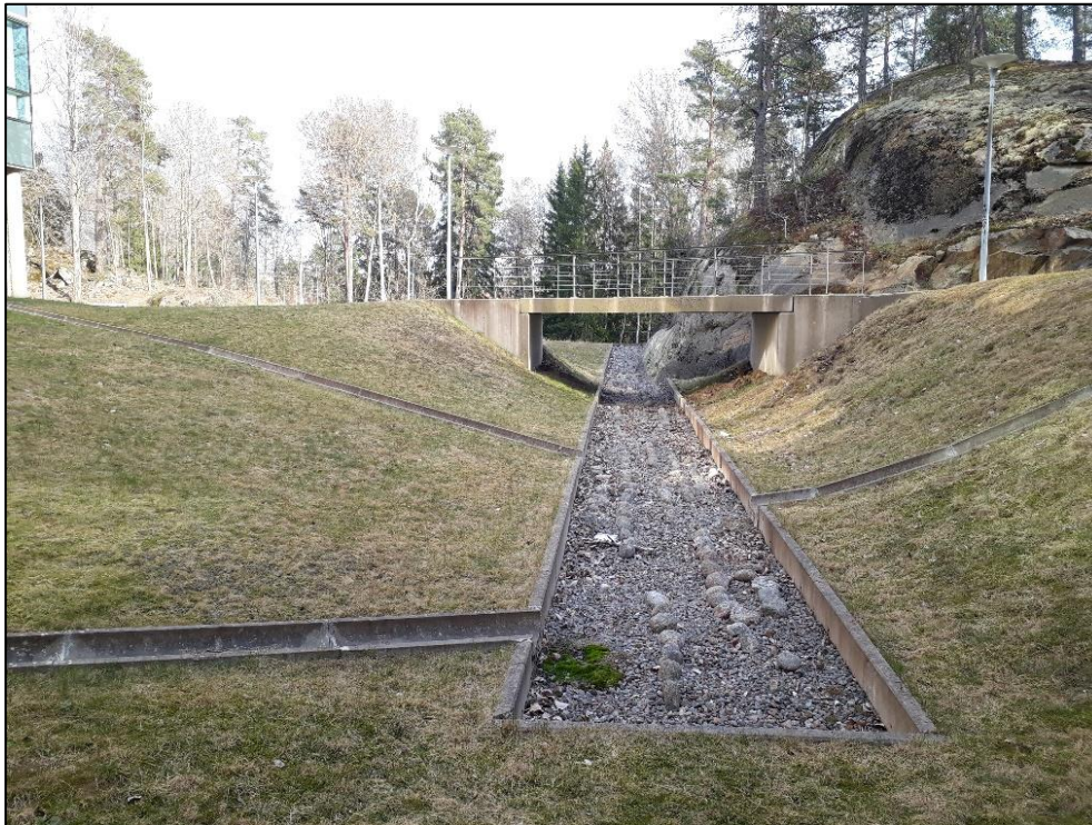
Figur 5. Öppen dagvattenkanal från byggnader norr om planområdet.
