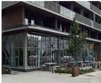
Sockelvåning med publik karaktär / Masthustorget 2015, Västra Hamnen Kirsh+Dereka Arkitekter
