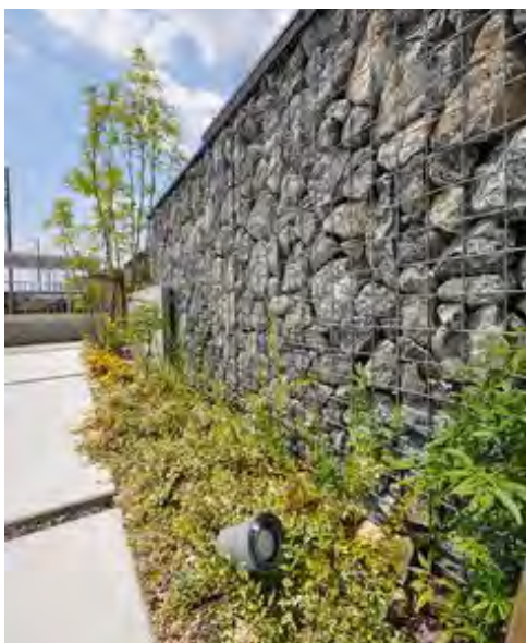
2. Exempel på gabionmur.
