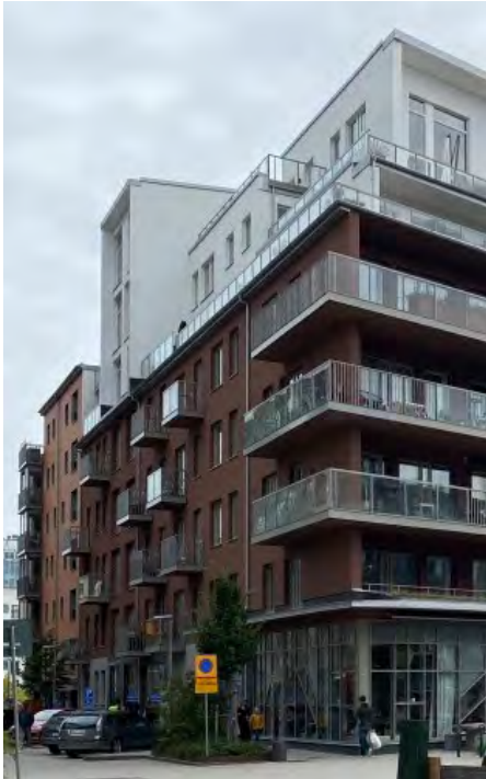
Korta och längre sammanhängande balkonger kombineras / Masthustorget 2015, Västra Hamnen, Kirsh+Dereka Arkitekter
