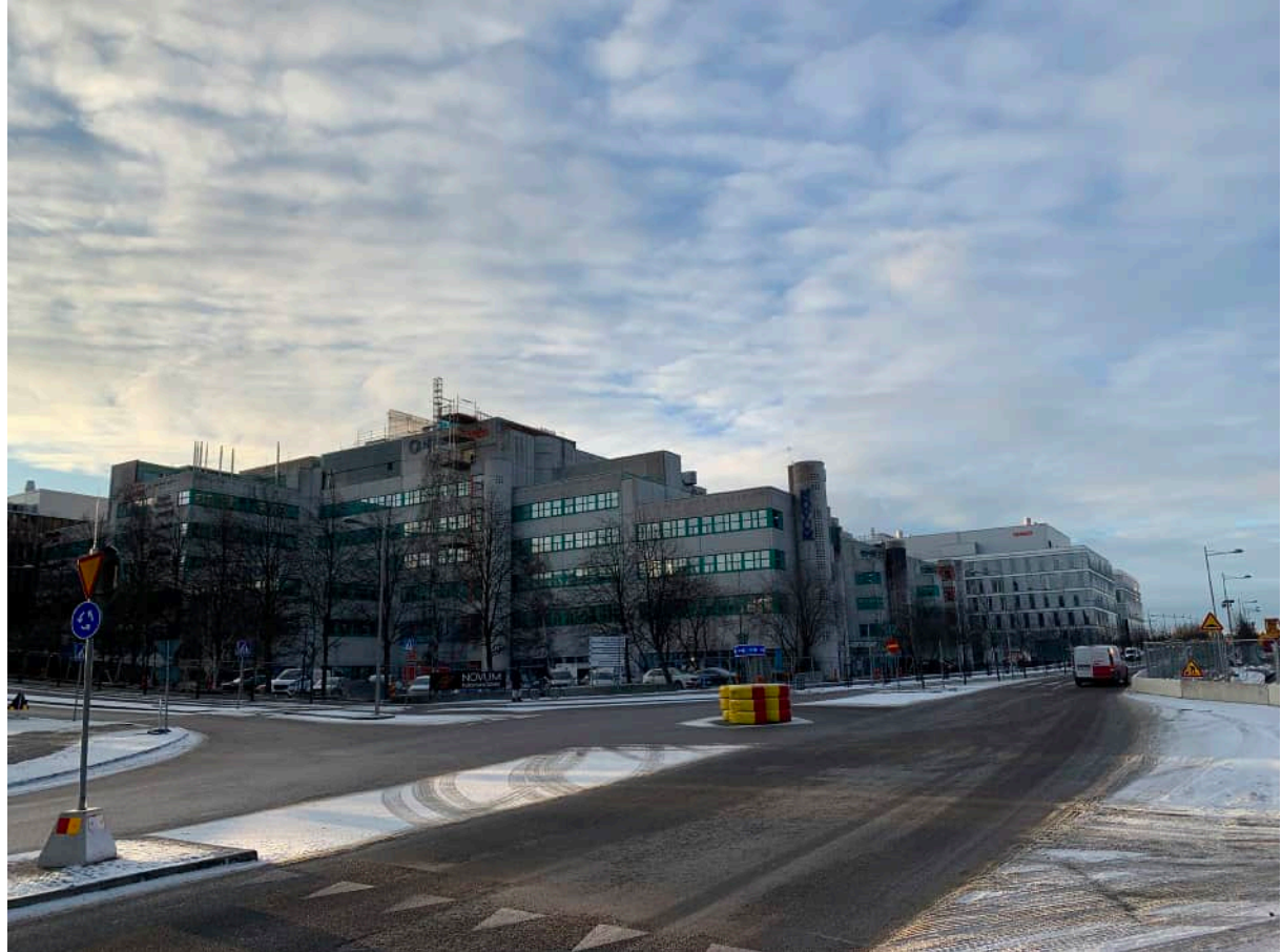
Nedtrappningen från Blickagången i söder mot Hälsovägen i norr är väl avläsbar.
