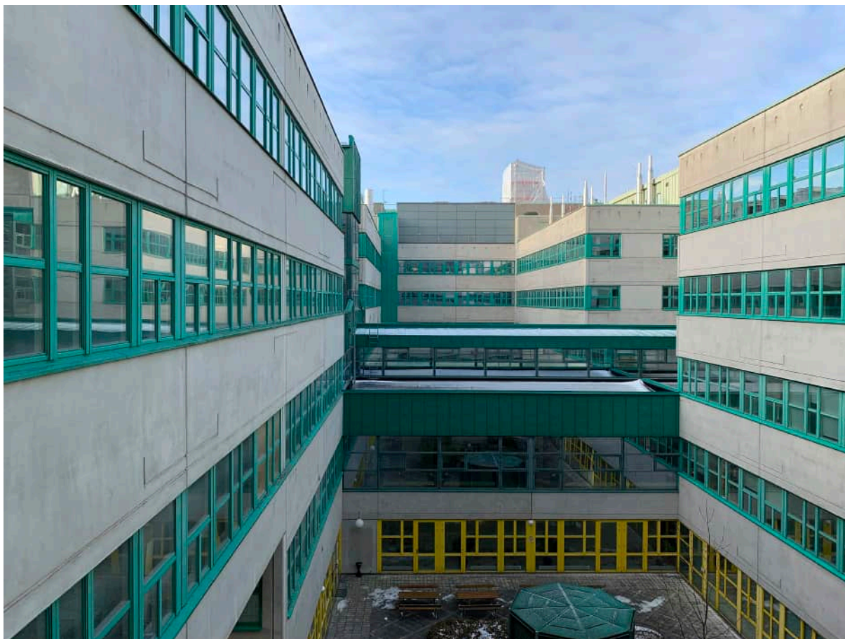
Innergårdarna var ursprungligen mer prunkande. Fasaderna har här behållit sin fräschör och ser i det närmsta fortfarande nya ut. Fönsterbanden med sina kraftiga kulörer och takens gröna plåt är viktiga karaktärsdrag.
