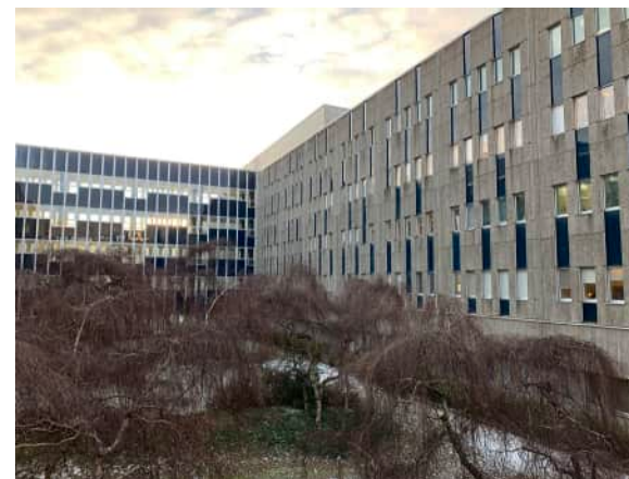
Sjukhusets fasader av bärande prefabricerade betongelement och blått glas. Foto Tyréns
