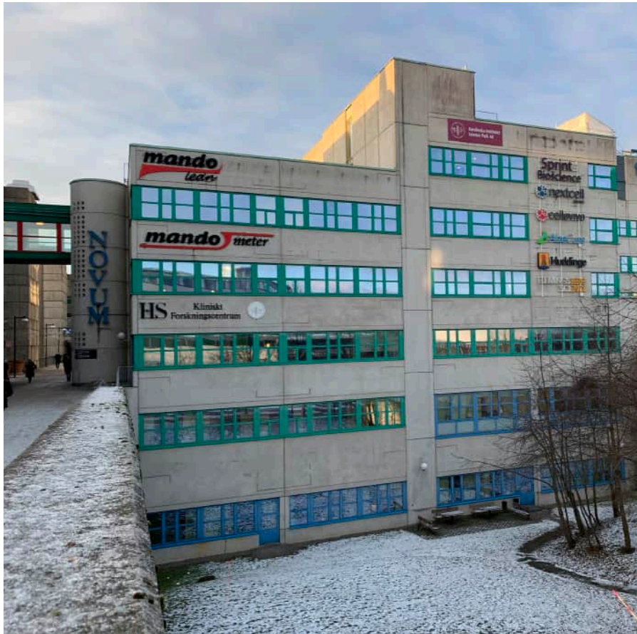
Novum från Blickagångens bro över Alfred Nobels Allé. Modulerna är väl avläsbara i fasad liksom de fristående utrymningstrapporna med sina karaktäristiska kvadratiska öppningar.
