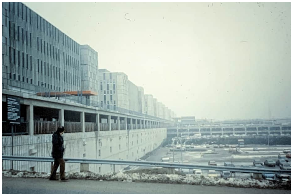
Den så kallade "gropen" där Novum kom att byggas. Till vänster den upphöjda gångvägen som ursprungligen enbart tjänade som utrymningsväg men i och med uppförandet av Novum blev ett nytt huvudstråk i området. Källa Anders Thalberg.
