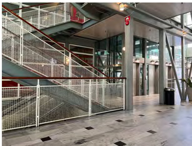
Trapphus och hissar i entréhallen.
