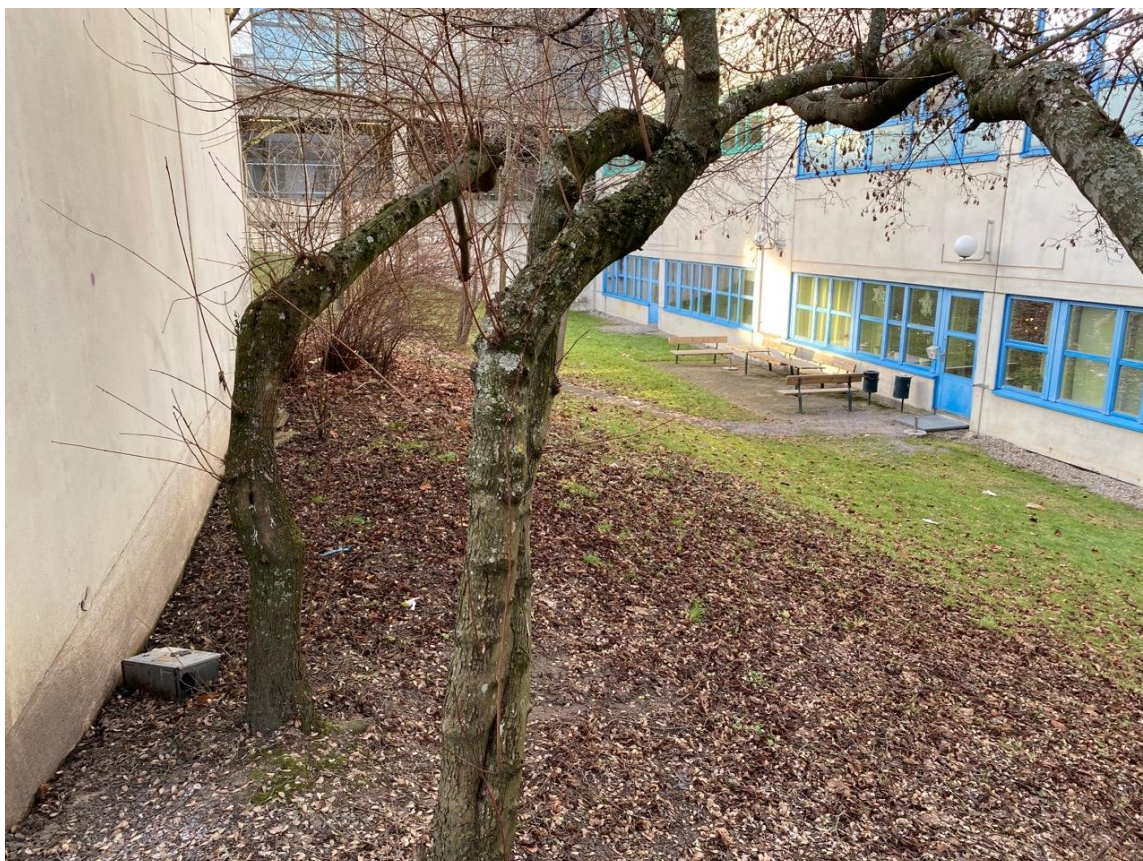
Figur 15. Befintliga entréer i anslutning av lågpunkt (F) utmed fasad. Entréerna är placerade en bit ovan marknivå. Bedömt maxdjup i lågpunkten är ca 15 cm.
