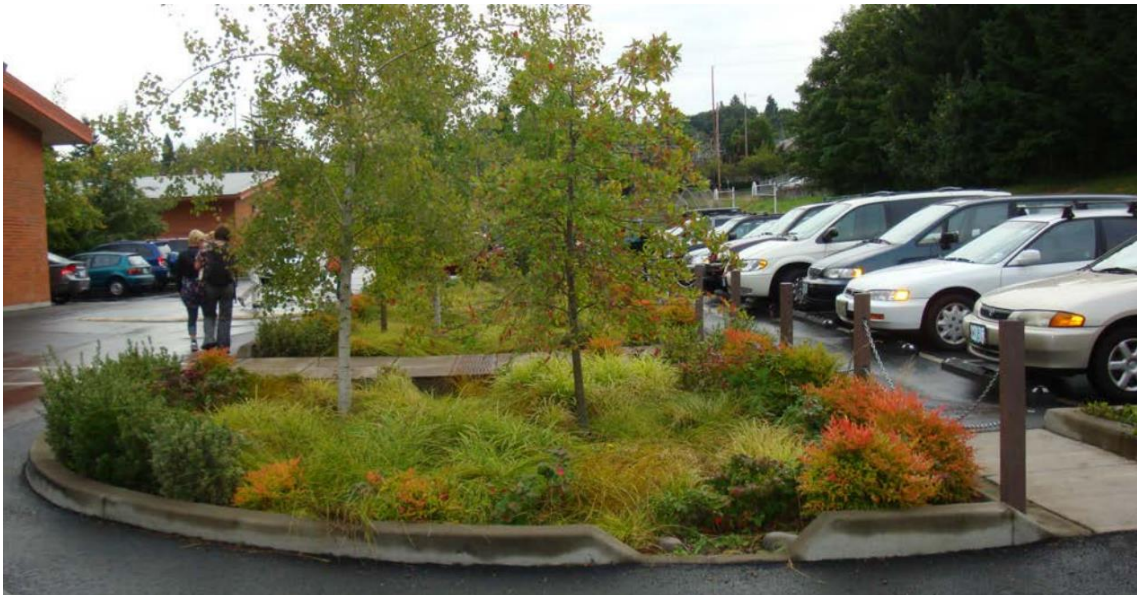
Figur 18. Växtfilterbädd i Portland, USA. Vatten från hårdgjorda ytor leds ytligt in i bädden via släpp i kantsöd. 15
