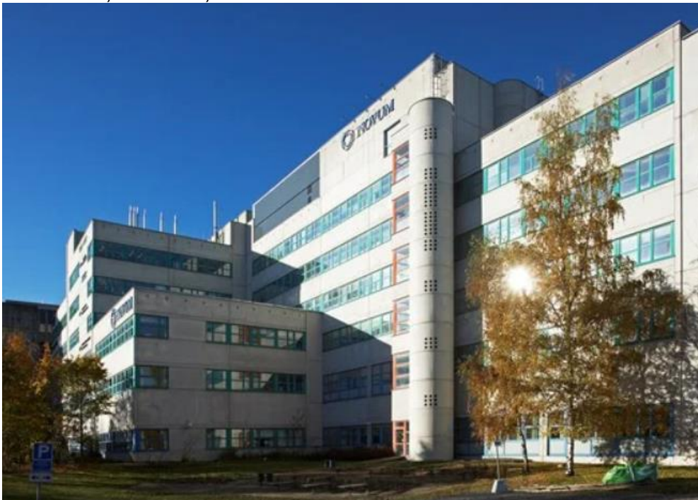
Figur 2 Befintlig byggnad Novum. Källa: https://www.hemso.se/fastighet/halsovagen-7/ .
