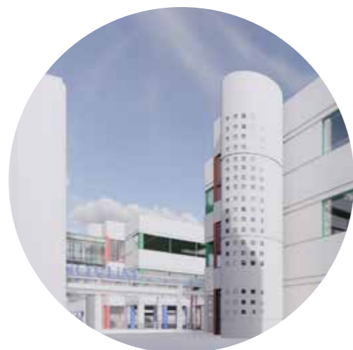
Befintlig entré mot Blickagången
