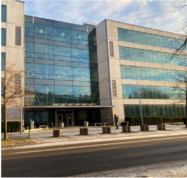
Befintliga entrésituationer längs med Alfred Nobels allé är mer markerade och omsorgsfullt gestaltade i jämförelse med dagens entrésituationer längs med Blickagången.
