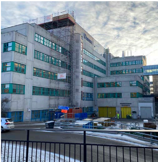
Infart från Hälsövägen till garage för besöksparkering samt varugodsmottagning. Denna upplevs idag som en baksida, stökig och ödslig.
