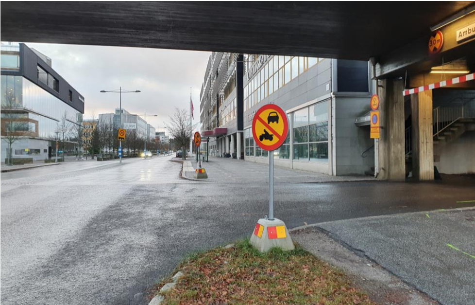
Figur 9 Infart till Sjukhusets väg under blickagången, foto på platsbesök december 2021
