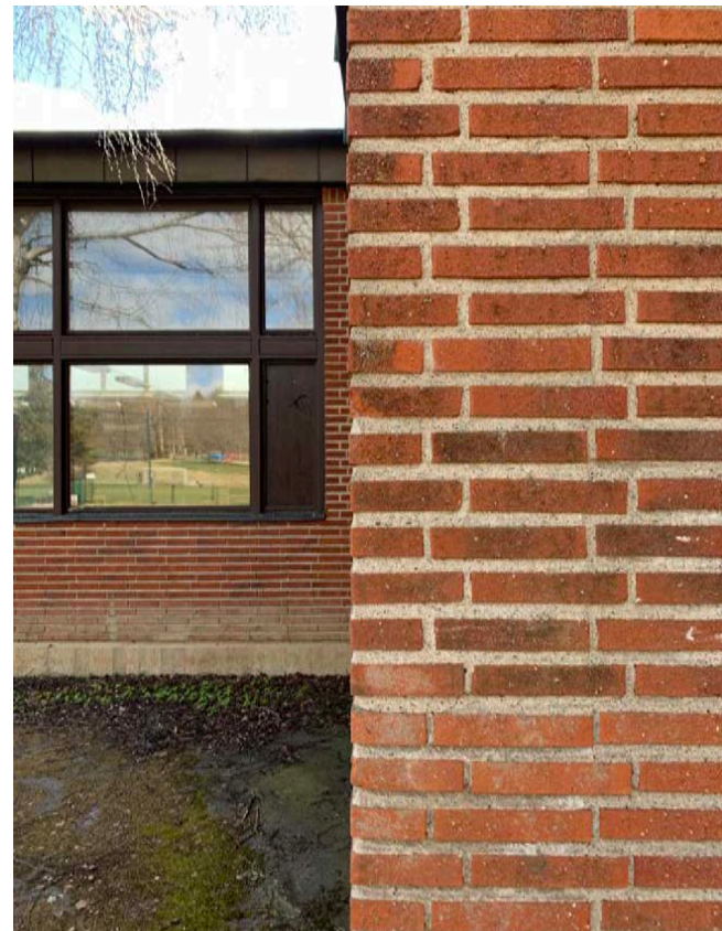
Detaljbild av den f.d. gymnastikbyggnaden. Ursprungliga träfönster löper i band över stora delar av fasaderna.
