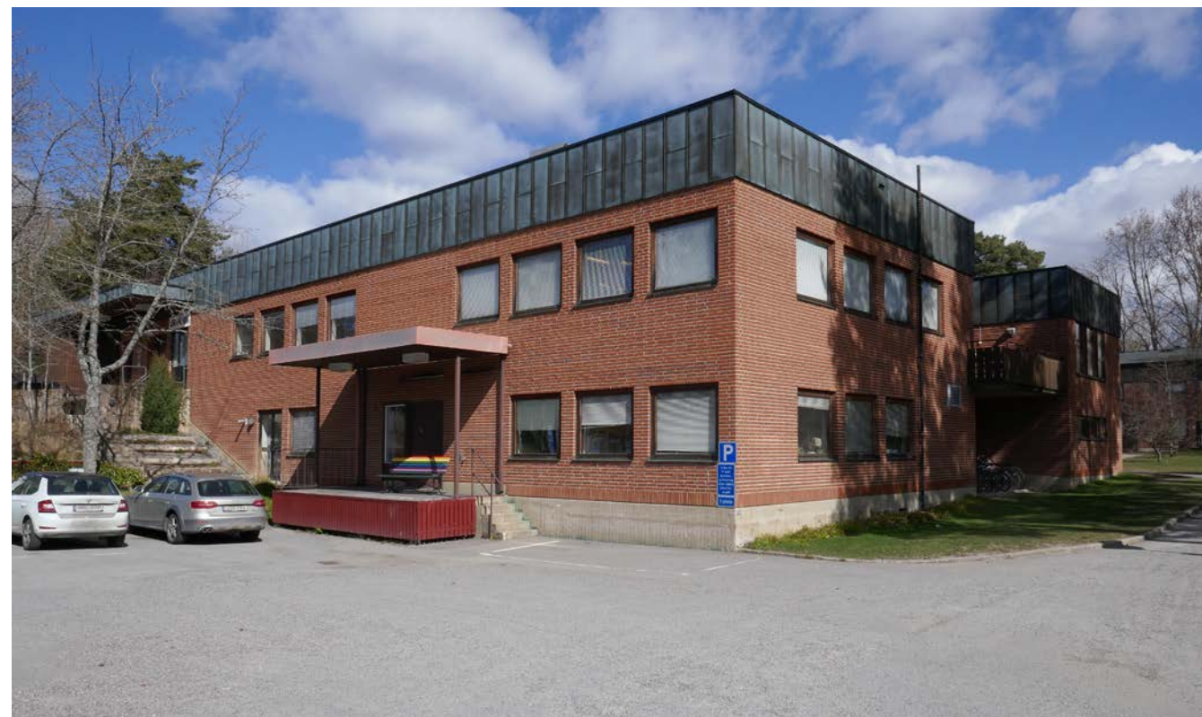
Del av skolanläggning. Arkitekturen är stram och anknyter till andra administrativa byggnader från denna tid.
