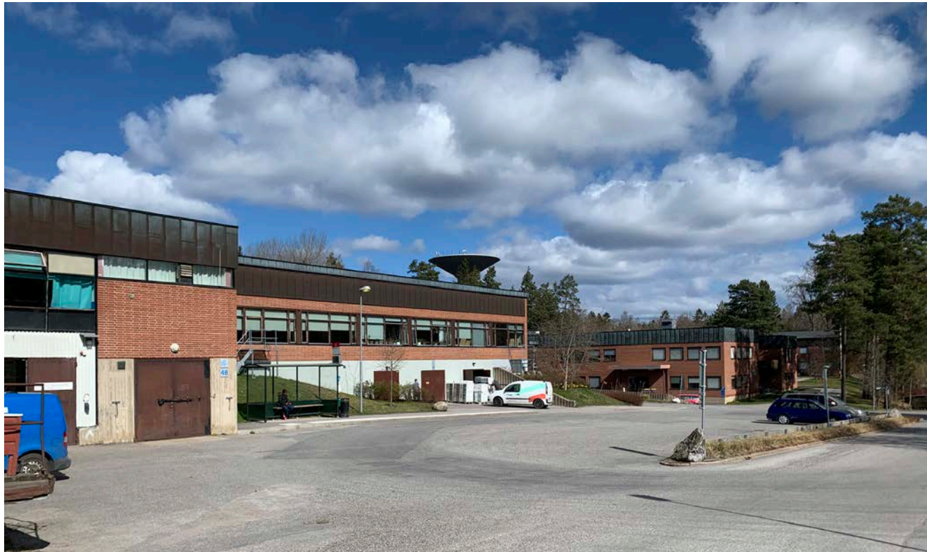
Hus 9. Södertörns friskola. Den f.d. centrumläggningen utgör en egen enhet i området vilket framgår av dess placering och avvikande utformning. Temat med tegelfasader och höga takfötter i kopparplåt återkommer dock i dessa byggnader.
