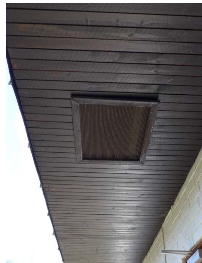
Djupt takutsprång klätt med träpanel.
