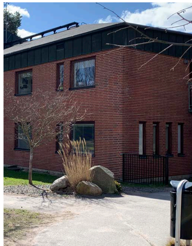
Del av skolanläggning.
