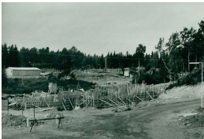
Björnkulla vårdhem under uppbyggnad. Stora delar av den äldre naturmarken bevarades. Källa: Huddinge kommun.
