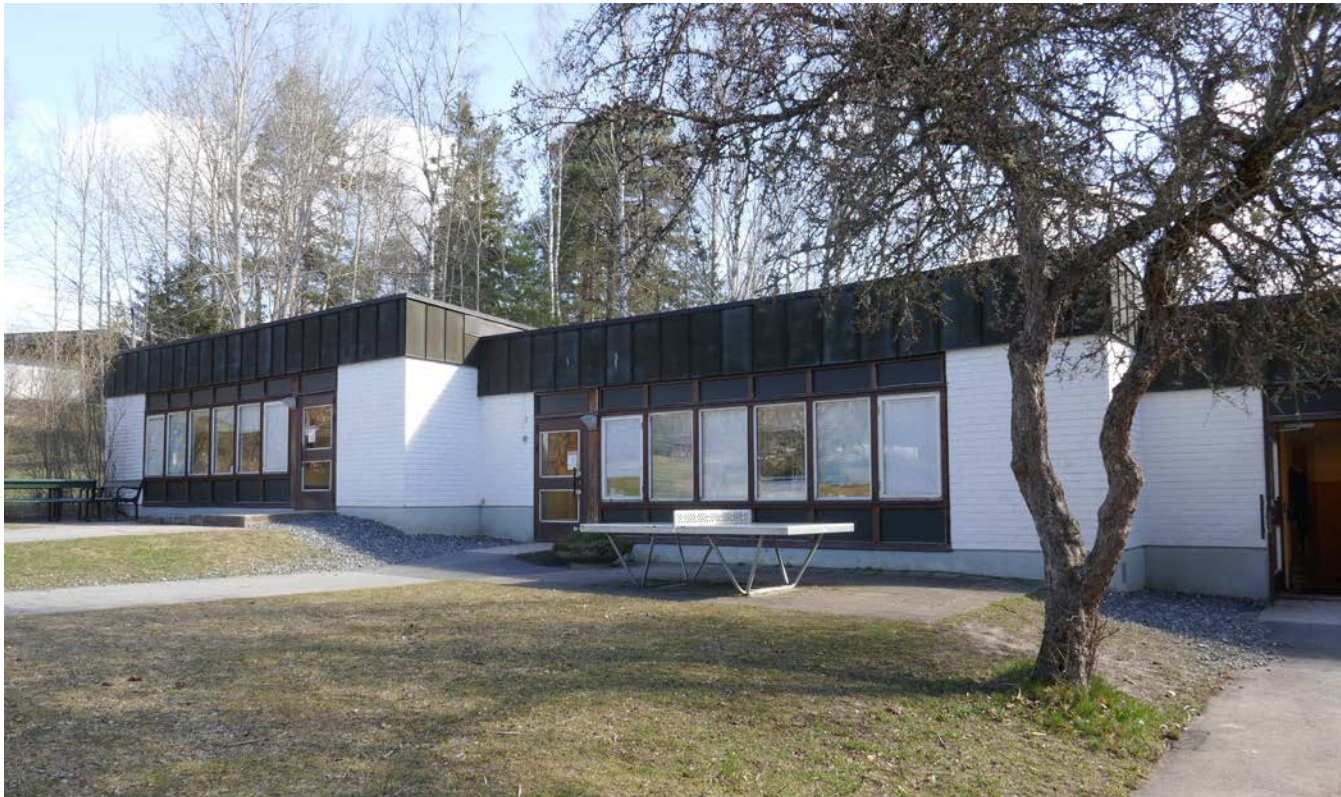
Hus 8. Byggnaden tillhör idag Södertörns friskola. Byggnaden har anpassats väl efter terrängen och de sammanfogade huskropparna markeras med indrag i fasaden.
