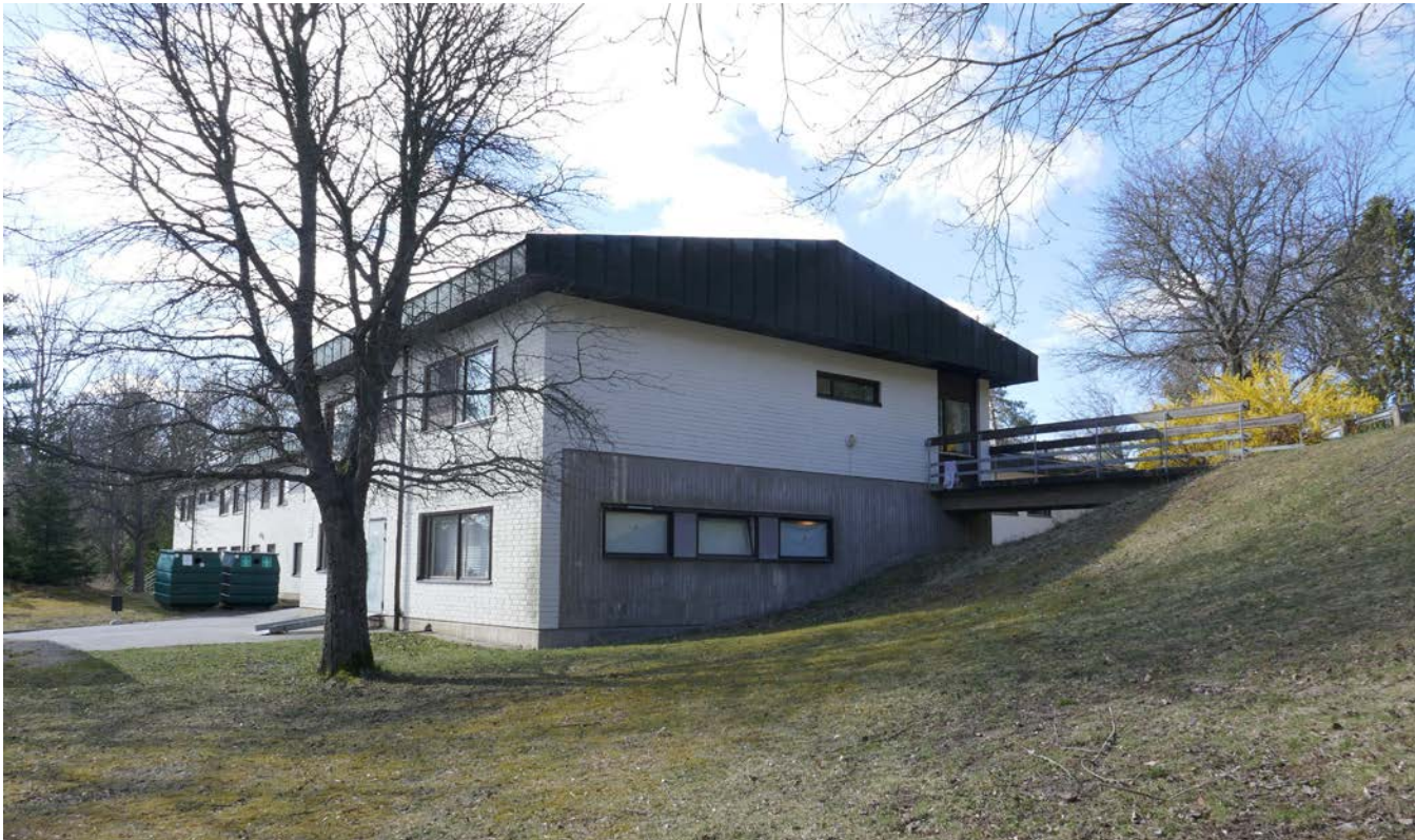
Hus 3. Solhem. Exempel på souterrängshus inom området.
