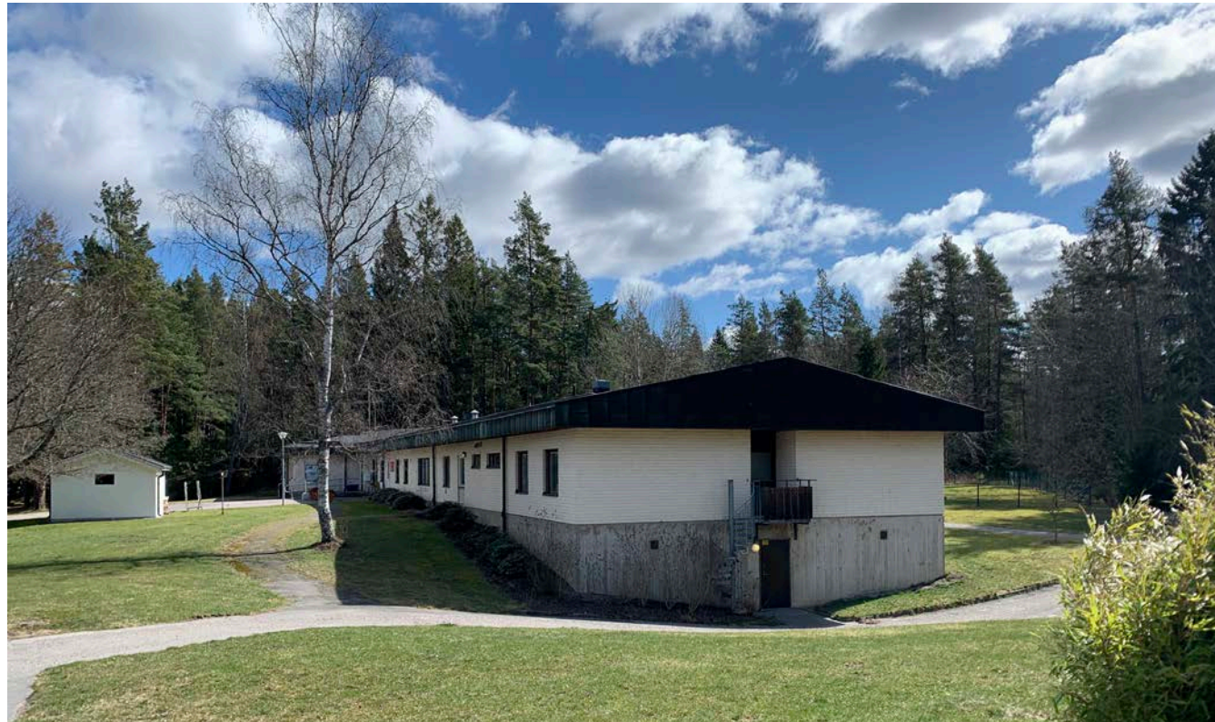
Hus 10. Graninge. Ett särskilt fint exempel på samverkan mellan topografi och bebyggelse inom området.
