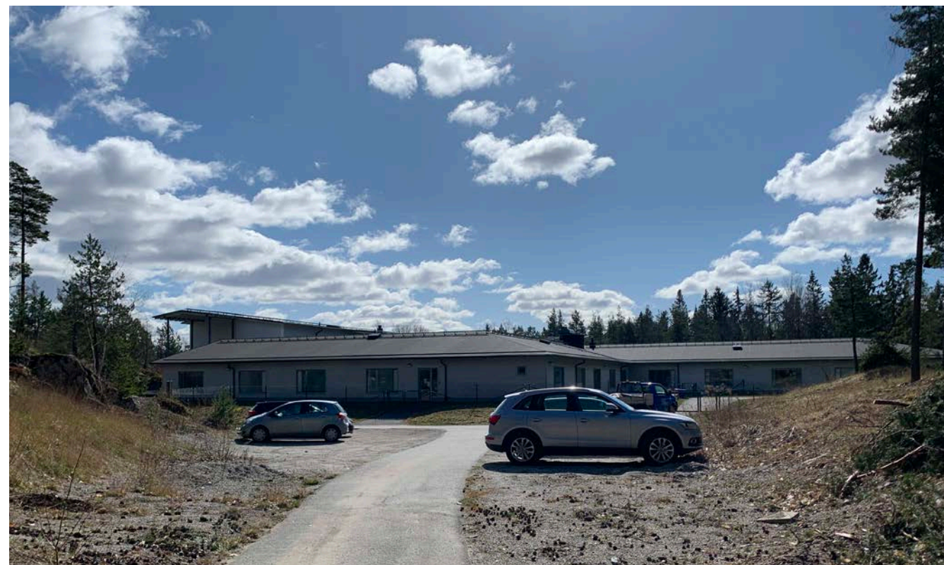
Hus 11. Tallåsen. Tillbyggd huskropp med fasadbeklädnad av liggande träpanel.
