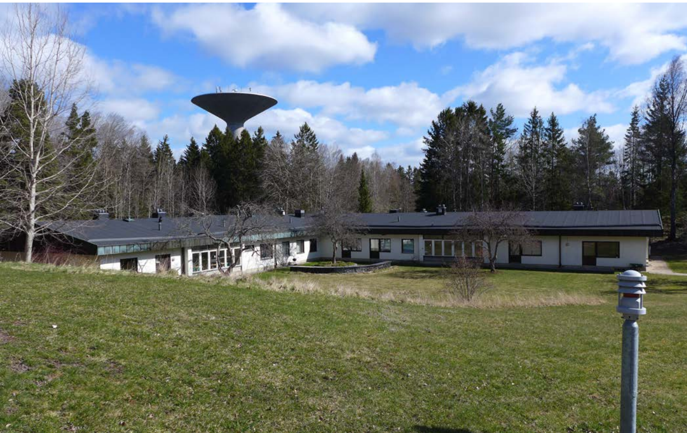
Hus 4. Haga. Gårdsrum i byggnadens vinkel som smälter samman med omkringliggande park.
