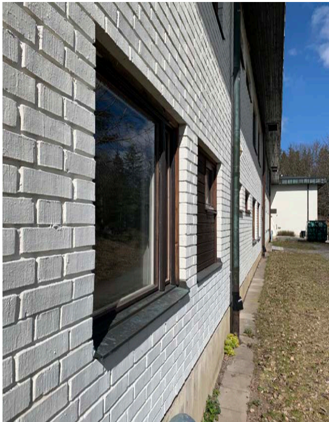
Vitmålade tegelfasader med djupa fogar, ursprungliga träfönster och detaljer av kopparplåt.
