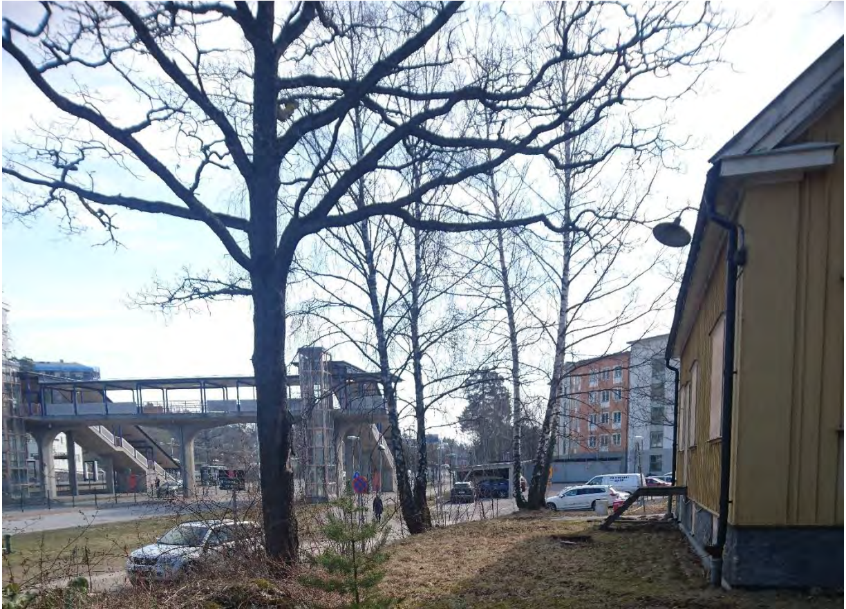
Figur 2. Foto längs med Magelungsvägen och mot Trångsunds station.
