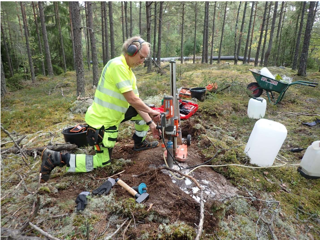
Figur 3-1. Handhållen kärnbormaskin med stativ, batteridrivna bormaskin för stativförankring, bensindrivna spänningsgenerator, vattenpump, vattendunkar och skottkärra är en del av utrustningen som krävs.
