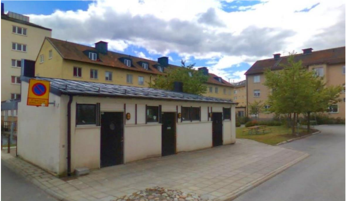
Figur 2. Befintlig byggnad för avfallshantering.
