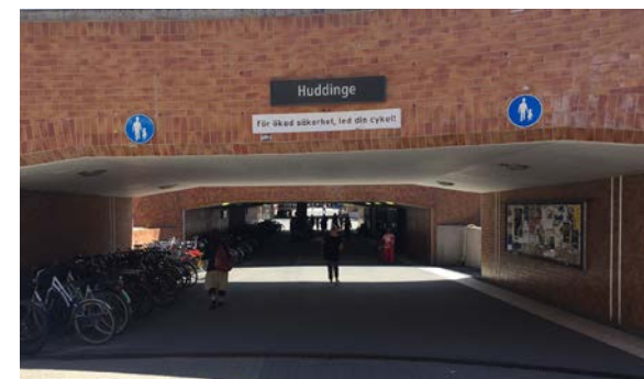
GÅNGTUNNELN SOM BINDER SAMMAN VÄSTRA OCH ÖSTRA SIDAN OM JÄRNVÄGEN HAR HÖGA GÅNGFLÖDEN OCH EN MÅLPUNKT I FORM AV HUDDINGE STATION
