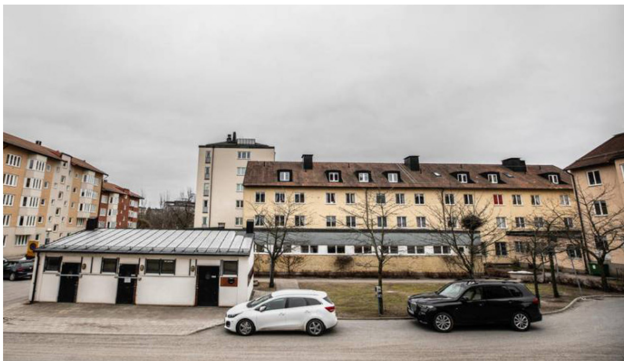
DET LÅGA MILJÖHUSET I FÖRGRUNDEN SAMT DEN LÄGRE TILLBYGGNADEN I ANSLUTNING TILL TREVÅNINGSHUSET RIVS I PLANFÖRSLAGET. BARNKÄLLAN OCH FUB HUDDINGE ÄR DE VERKSAMHETER SOM IDAG ANVÄNDER SIG AV DESSA LOKALER (FOTO: CLAUDIO BRITOS, 2021).
