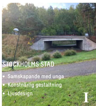
28: Åtgärder i gångtunneln (Stockholm)
