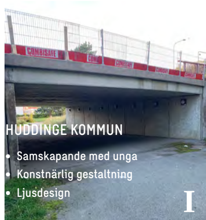
27: Åtgärder i gångtunneln (Huddinge)
