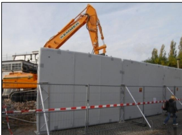
Figur 3. Exempel på skärmning vid källan i samband med anläggningsarbete
