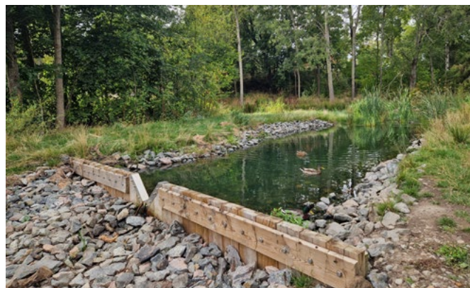
Ny dagvattendamm vid Mörtviksvägen. Foto Erik Sundin
