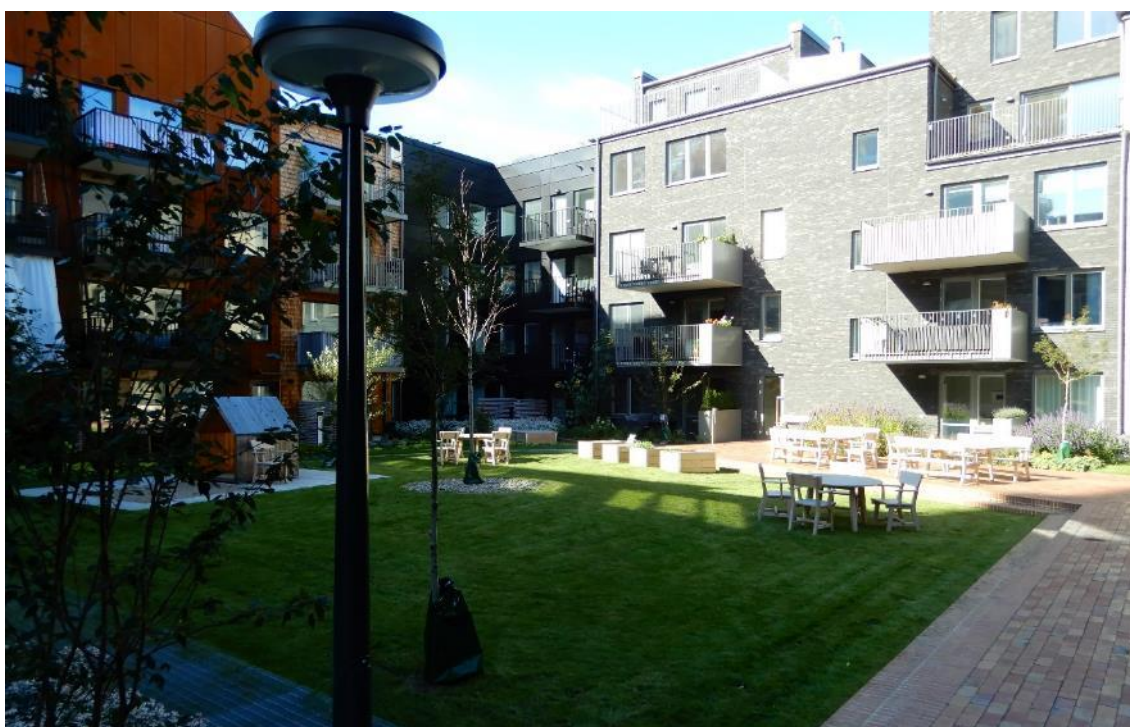
Figur 21. Exempelbild på en gräsyta på bjälklag som tar emot dagvatten från omkringliggande takytor genom tillförsel underifrån (Tyresö centrum). Foto: WRS.
