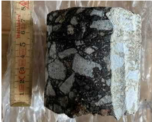
Bild 1. Asfaltkärna från provpunkt 21G13
