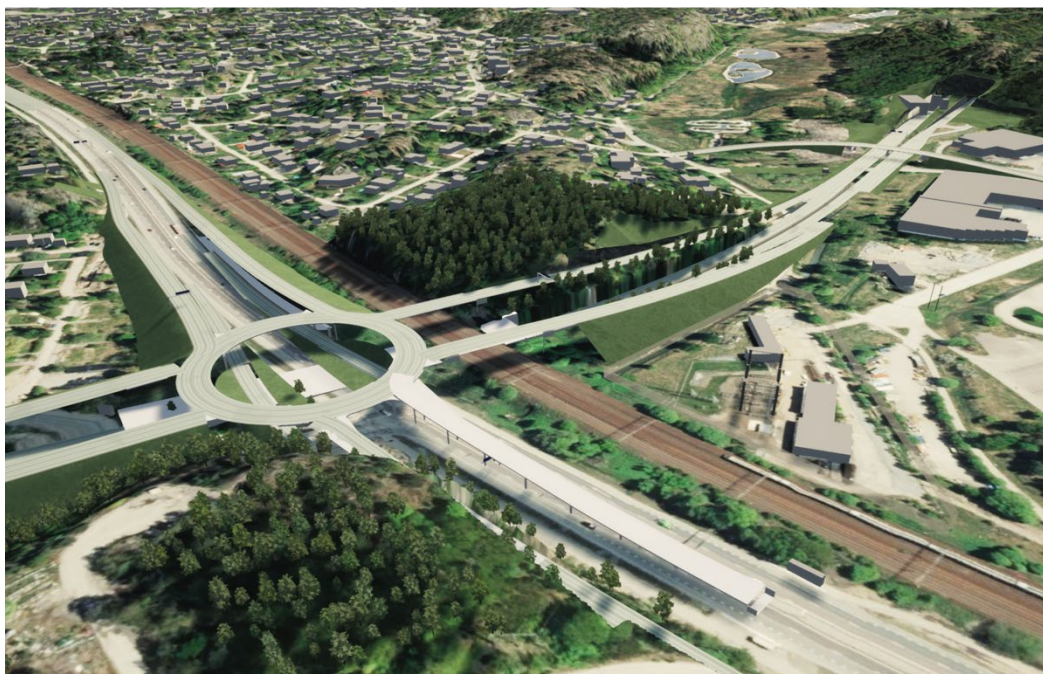
Figur 4. Trafikplats Solgård sett från sydväst (Trafikverket, 2018).
