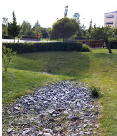
Figur 7. Exempelutformning av makadam/krossdike hämtade från Stockholm Vatten och Avfall. 8 Tänkt LOD-lösning för avrinningen från gårdsyta och avrinning från tak med lutning mot gård. Rasterytan i figuren ersätts på större delen av mer skålad grön dikesanvisning för rening. I den vänstra delen kan ev. kross i ytan läggas för att kunna hantera större flöden vid intensiv nederbörd.
