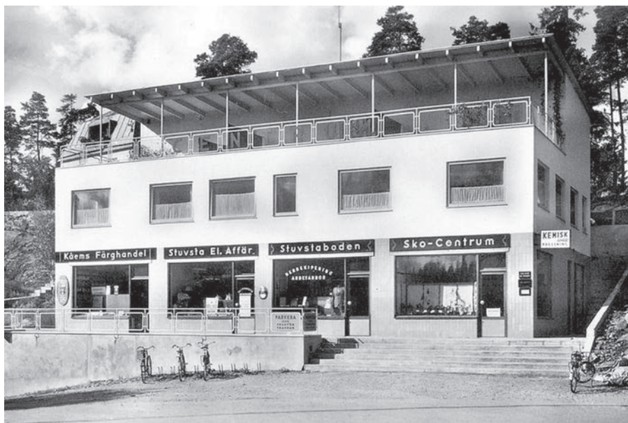
t.v: Centrumhuset uppfört år 1938 efter arkitekt Sven Jonsson. Byggnaden fick en intressant arkitektur med öppen övre våning med funktionalistisk utformning.
