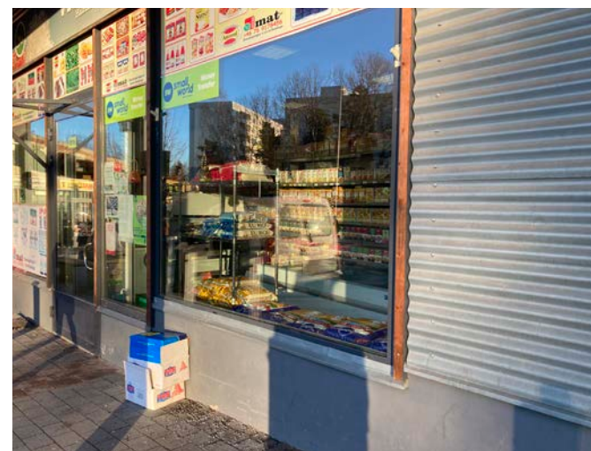
Fasader i korrugerad plåt möter putsad sockel och fönsterbågar i trä. Materialkombinationen påminner om miljonprogrammets materialpalett.
