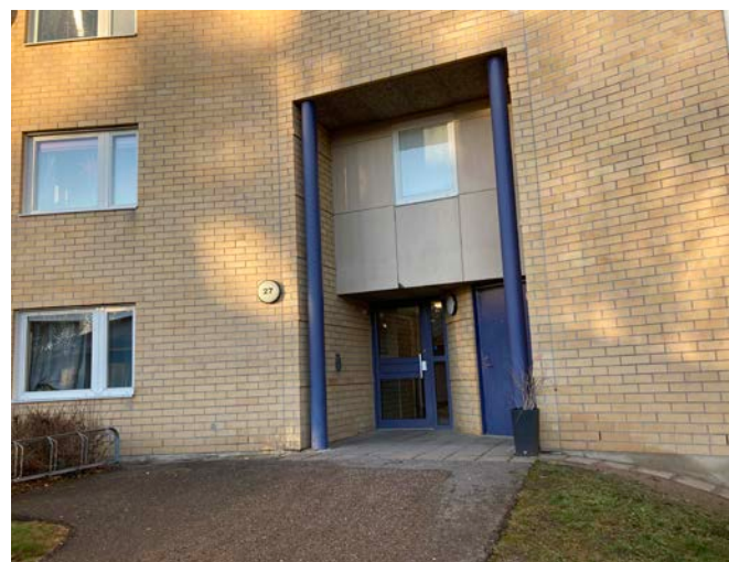
Indragen entré. Ovan portdörren finns en putsad yta. Det indragna partier stöds av pelare.
