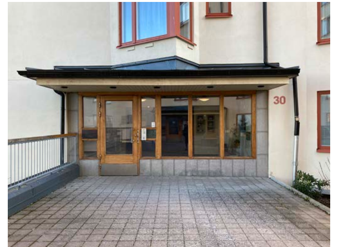
Diskreta indragna entréer som omges av omfattning i natursten. Till vänster syns ursp. belysning. Portdörrar är sentida.
