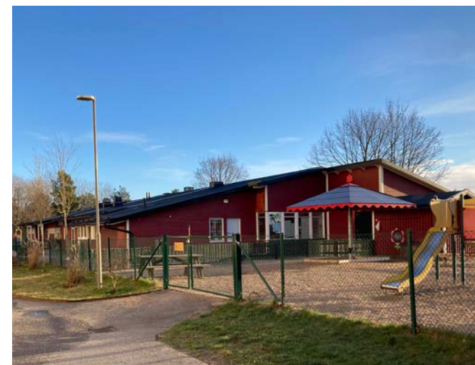
Förskolebyggnaden med del av omgivande gård, sedd från väst. På gaveln syns tillbyggnaden.
