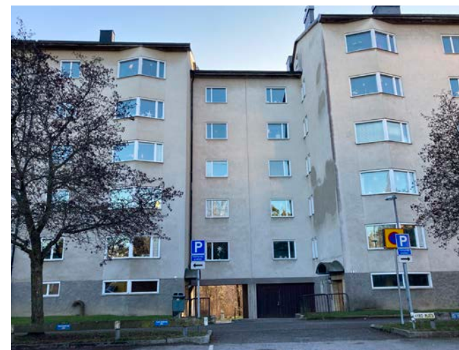
Uppbruten fasad med överbyggd gång. Till höger syns ett panelklätt fasadparti. Sockeln har en grövre puts. Liggande mindre fönster på sockel.
