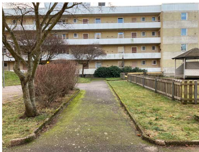
Del av gårdsrum med indelade grönytor. I fonden syns en av byggnaderna med sina tidstypiska loftgångar.
