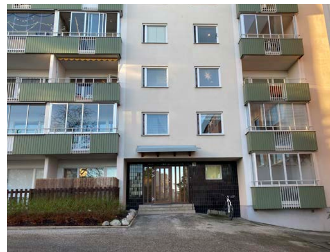
Diskreta indragna entréer som omges av omfattning i natursten. Till vänster syns ursp. belysning. Portdörrar är sentida.
