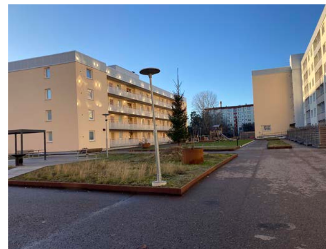
Parallellt ställd bebyggelse. De norra bostadshusen är sammanbyggda på rad men något förskjutna vilket skapar mer vinklar i gårdsmiljön.
