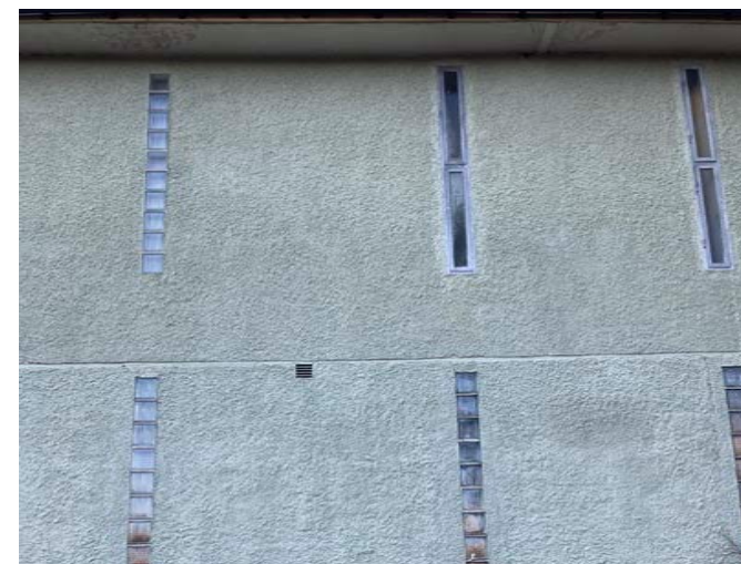
Långsmala fönster med betongglas. Fasaden är grovputsad
