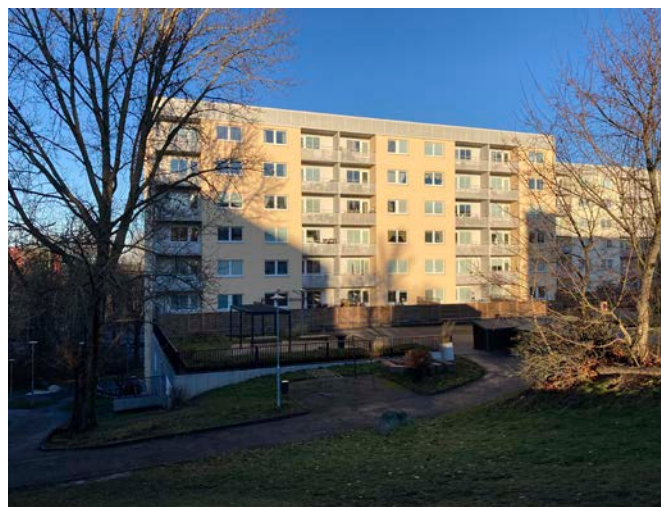
Höga betongmurar i den västra delen bidrar till att plana ut innergården.
