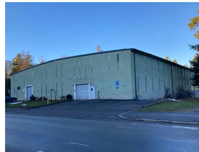
Byggnadens södra gavel. Den robusta volymen ger ett vilande uttryck. Sadeltaket är flackt.
