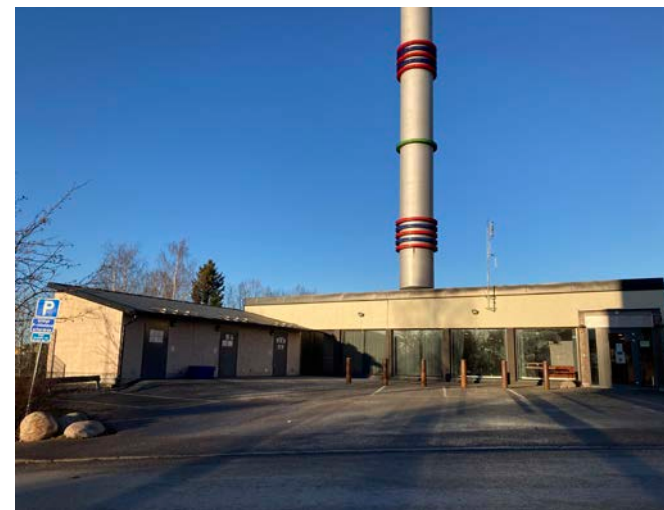
Den tidigare panncentralen möts av en plan asfalterad yta. I dess västra del finns en mindre tillbyggnad.
