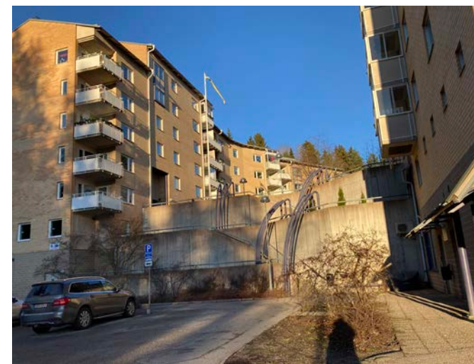
De långa flerbostadshusen är uppförda suterräng. Trappa med tidstypisk gestaltning leder upp till gården.
