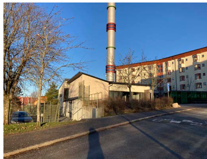
Byggnaden är uppförd i suterräng. Stödmurar bidrar till att jämna ut marken. I väster angränsar ett promenadstråk.
