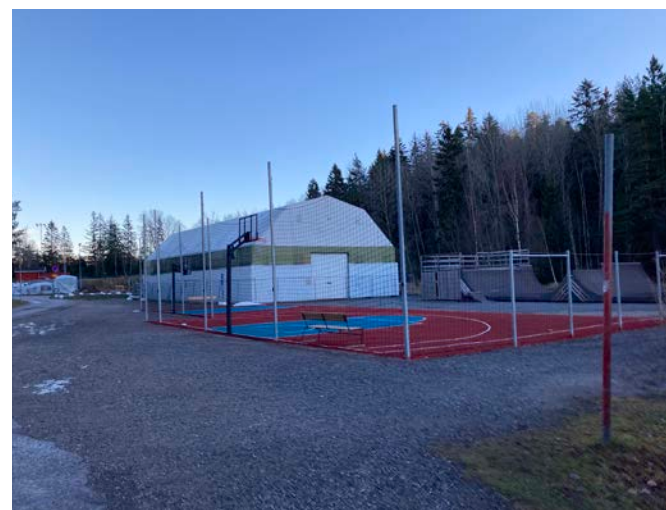
Storskaliga ytor ansluter till byggnaderna med utrymme för att utöva diverse sportaktiviteter.
