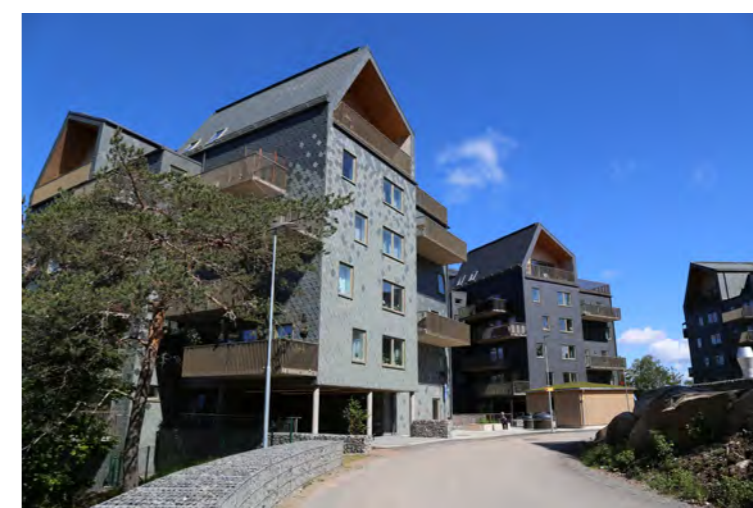
Exempel på bebyggelsemiljö i överensstämmelse med gestaltningprinciper för karaktärsområde 2. UGGLEBERGET, Nya Hovås, Göteborg. Foto: Familjebostäder i Göteborg. Arkitekt: Fojab
