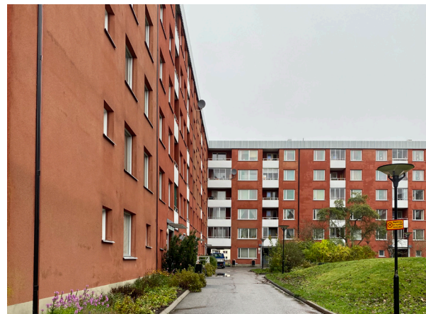
Gångväg på innergård längs med Visättravägen
