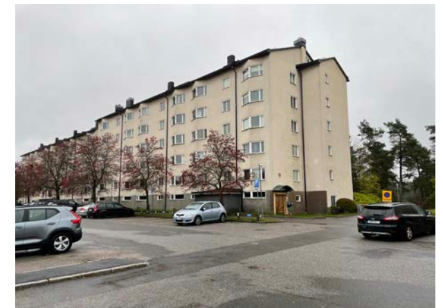
Bebyggelse och markparkering längs med Visättravägen.
