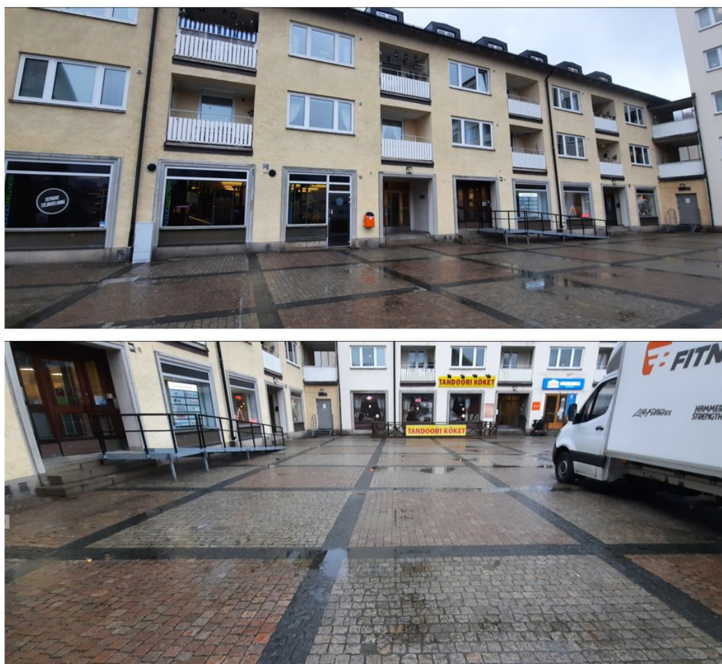
Figur 12 Takavvattning av bebyggelse på Fullerstatorget via hängrännor och stuprör.
