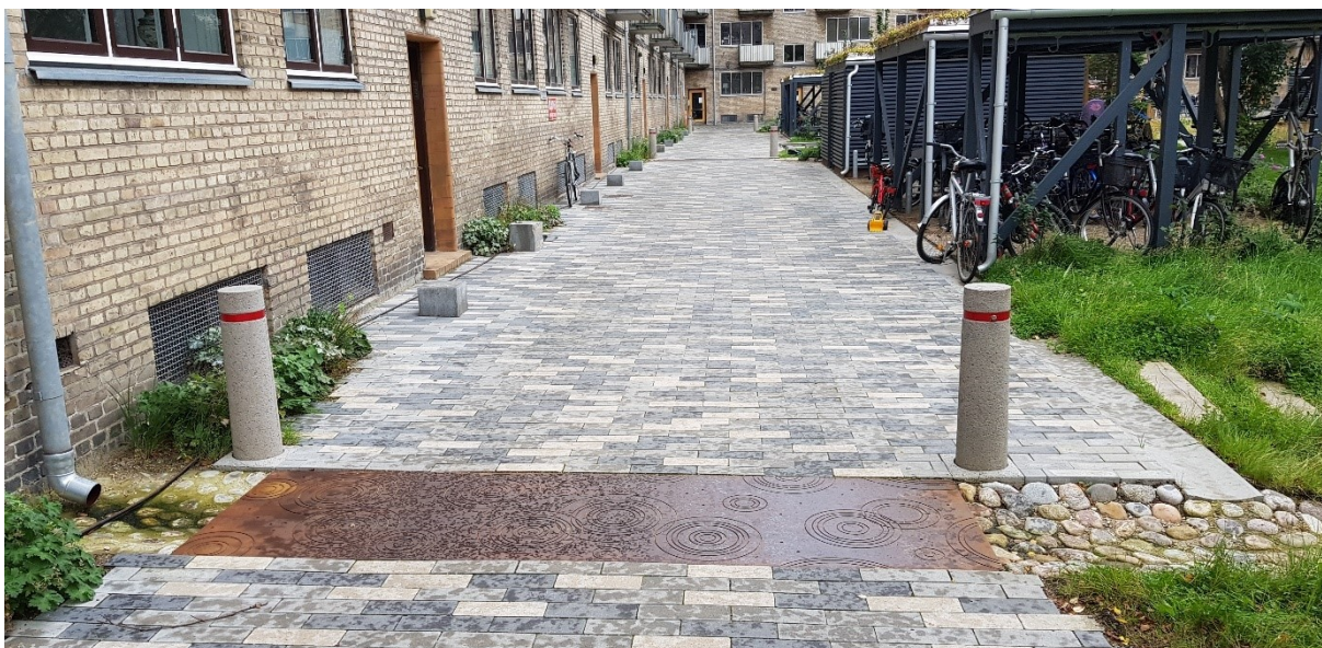
Figur 24 Exempel på en anläggning som leder vattnet från takytor (stuprör) till grönytor i Köpenhamn. (Bildkälla: Joakim Scharp)
