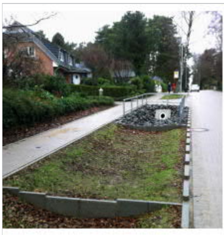
Figur 12. Svackdike med inloppsledning och dämnen. Foto: WRS.
