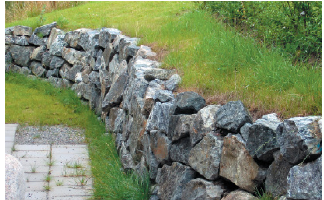
Referensbild stödmur. Hantering av slänt på tomtmark med stödmur. Bild: Huddinge Kommun
