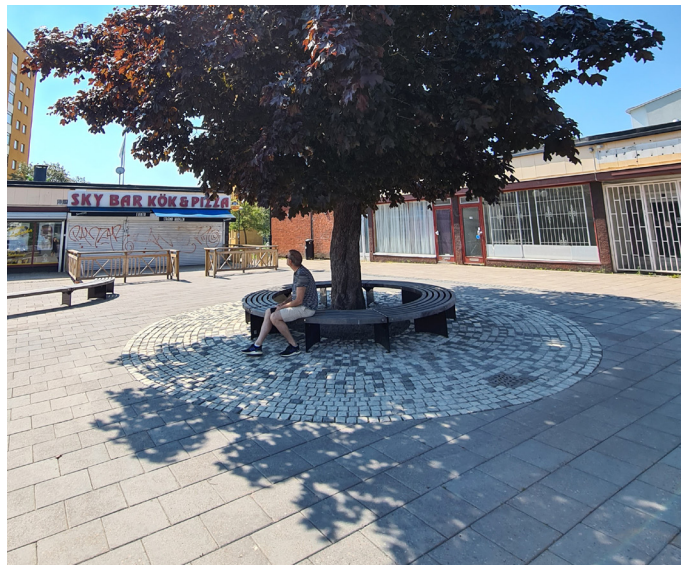
En bas av betongplattor i enkelt mönster kompletteras med smågatsten i kontrasterande kulör och läggningsriktning.
