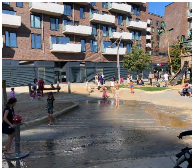
Figur 5-6. Exempel på lekplats med lågt placerade ytor/lågstråk till vilka skyfallsflöden kan ledas för fördröjning vid kraftig nederbörd. Lekytorna är i detta fall dessutom utrustade med färskvattenpumpar för vattenlek i torrväder. Foton: Annika Persson.
