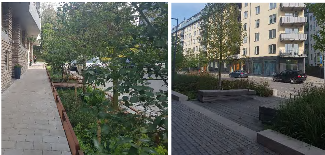
Figur 5-7. Exempel på nedsänkta växtbäddar med träd som tar emot vägdagvatten för rening och fördröjning. Foton: Therése Ingerdal.
