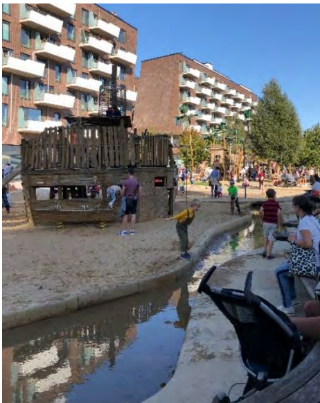
Figur 5-6. Exempel på lekplats med lågt placerade ytor/lågstråk till vilka skyfallsflöden kan ledas för fördröjning vid kraftig nederbörd. Lekytorna är i detta fall dessutom utrustade med färskvattenpumpar för vattenlek i torrväder. Foton: Annika Persson.
