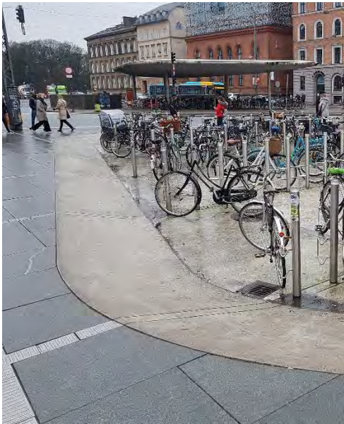
Figur 5-5. Exempel på nedsänkta ytor i gatu/torgmiljö som fungerar som fördröjningsyta (inklusive rening i det högra fallet) för dagvatten. I den nedsänkta cykelparkeringen sker avtappning genom dagvattenbrunnar i botten. I anläggningen till höger finns ett bräddutlopp till dagvattenledning en bit över bottennivån på planteringen. Foto till vänster: Karin Henrikson, foto till höger: Jimmy Norrman, Funkia AB.
