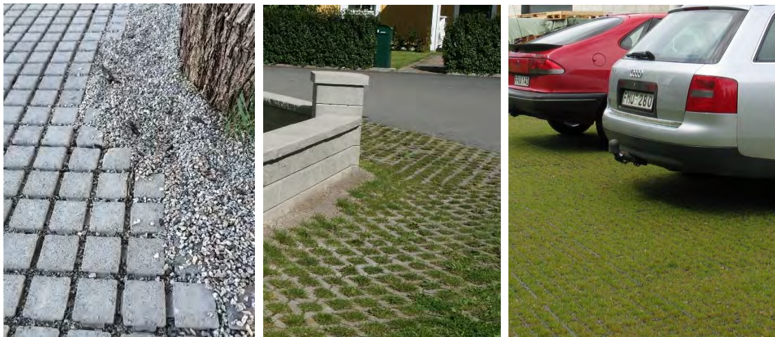
Figur 5-8. Exempel på genomsläpplig markbeläggning: stensättning, gräsarmering och pelleplattor (foto Annika Persson, Benders och VegTech).
