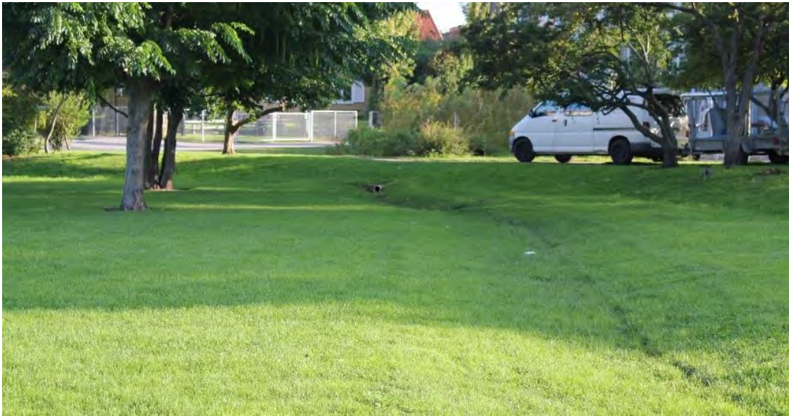
Figur 5-3. Exempel på svackdike för vägdagvatten i allmän park som fungerar som gräsyta/lekyta i torrväder. Foto: Annika Persson.
