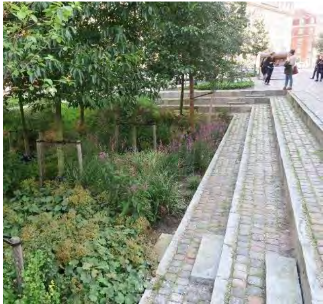
Figur 5-5. Exempel på nedsänkta ytor i gatu/torgmiljö som fungerar som fördröjningsyta (inklusive rening i det högra fallet) för dagvatten. I den nedsänkta cykelparkeringen sker avtappning genom dagvattenbrunnar i botten. I anläggningen till höger finns ett bräddutlopp till dagvattenledning en bit över bottennivån på planteringen. Foto till vänster: Karin Henrikson, foto till höger: Jimmy Norrman, Funkia AB.
