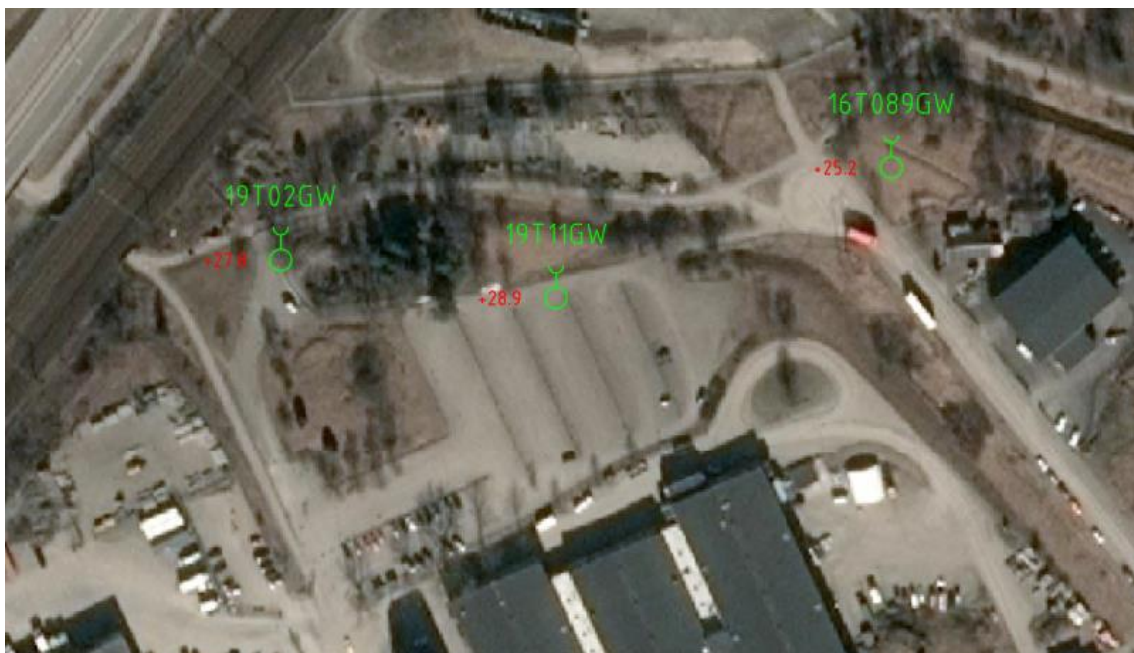
Figur 2: Översikt över lägen för installerade grundvattenrör.
