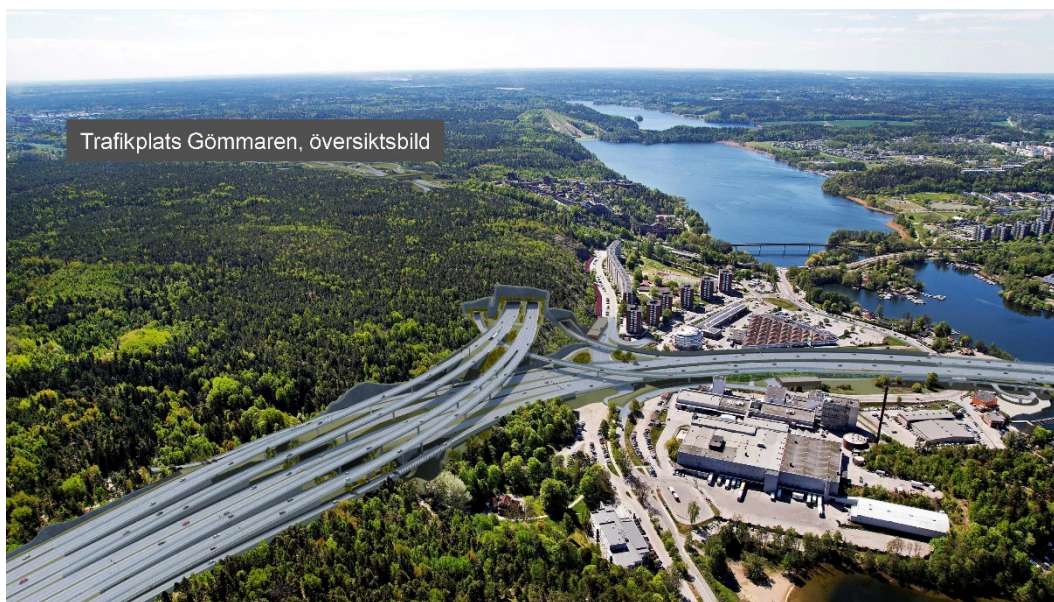
Figur 7: Illustration över Tvärförbindelse Södertörns med vy öster ut. Här redovisas kopplingen mellan E4/E20 och Tvärförbindelse Södertörn. Av- och påkörningsramper från E4/E20 svänger öster ut och in i Masmoberget. Rendering gjord av Trafikverket.
