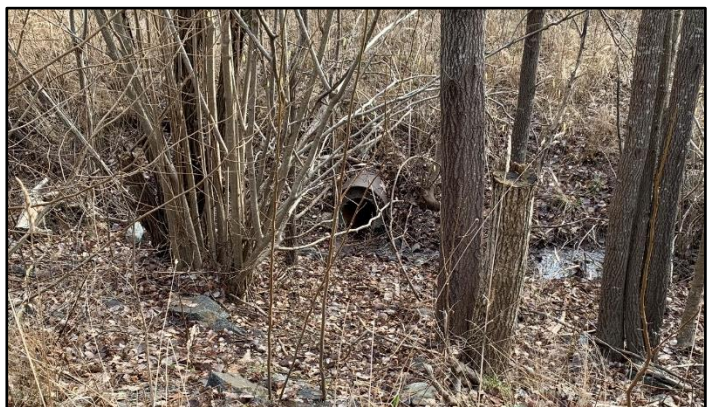
Bild 5. Foto visande befintlig trumma under järnväg, belägen i söder och mottagare av planområdets södra del.
