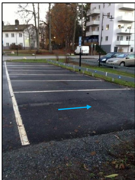
Figur 16. Parkeringsplats anlagd med asfalt. Med hjälp av skevning av den asfalterade ytan avrinner dagvatten till ett grönstråk. Lösningen leder till minskad avrinning från området och lokal rening av dagvatten.
