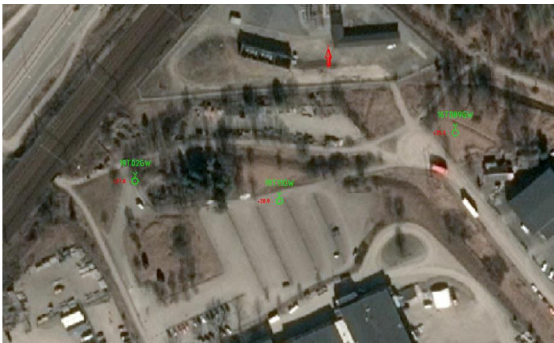
Figur 2: Översikt över lägen för installerade grundvattenrör.
