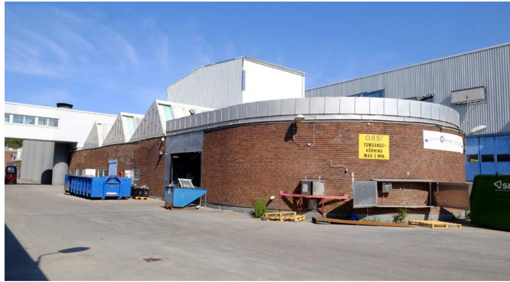
Verkstadsbyggnaden (K), östra kortsidan och östra delen av södra fasaden.
