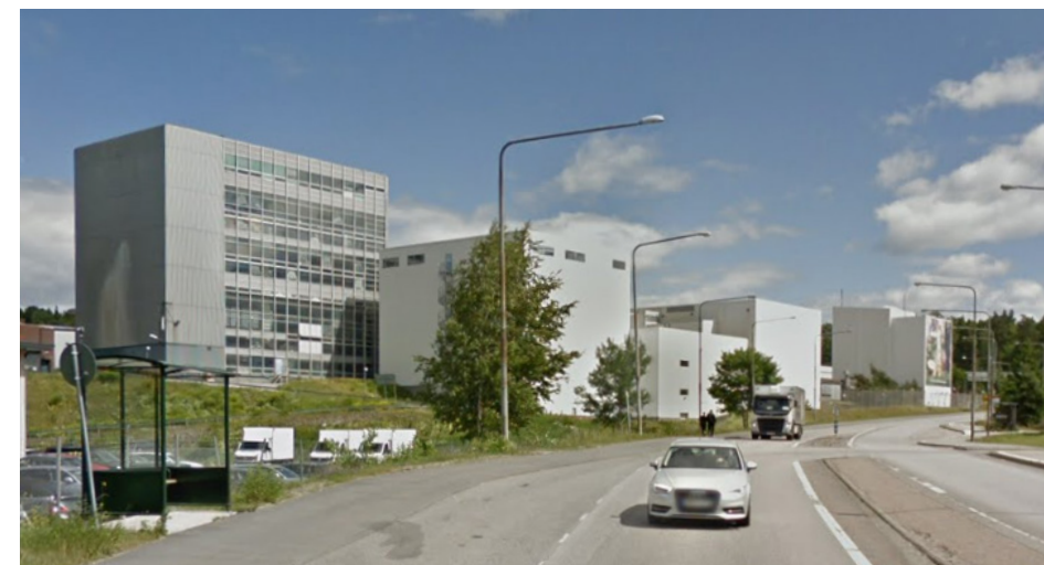
29. Brygghuset och tapphallen från sydväst 2017 (Google Street View).
