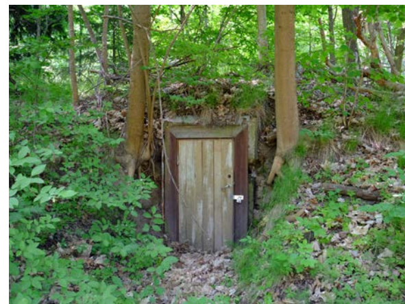
Jordkällare vid trädgårdsmästarebostaden.
