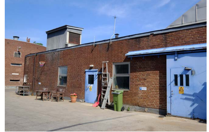
Verkstadsbyggnaden (K), västra delen av södra fasaden.
