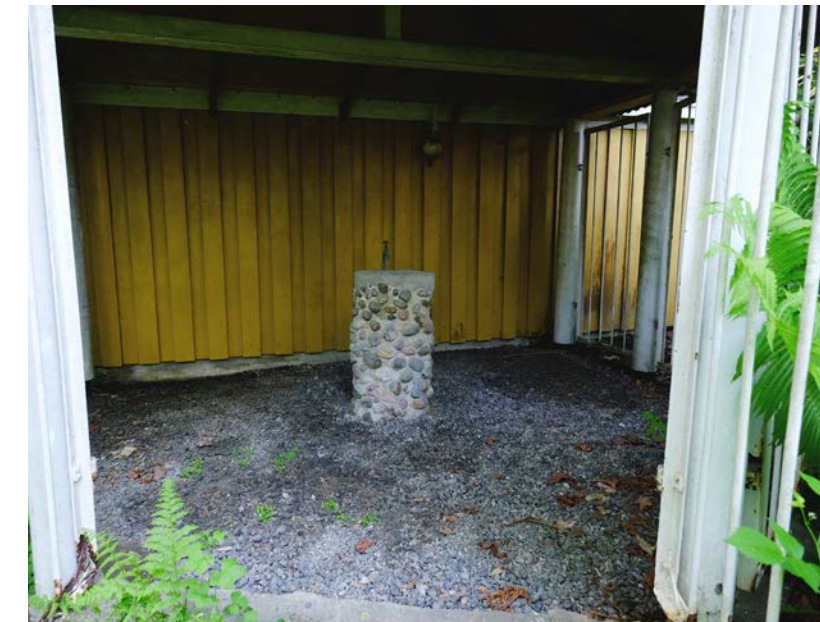
Kioskbyggnaden invändigt, med dryckesbrunn.
