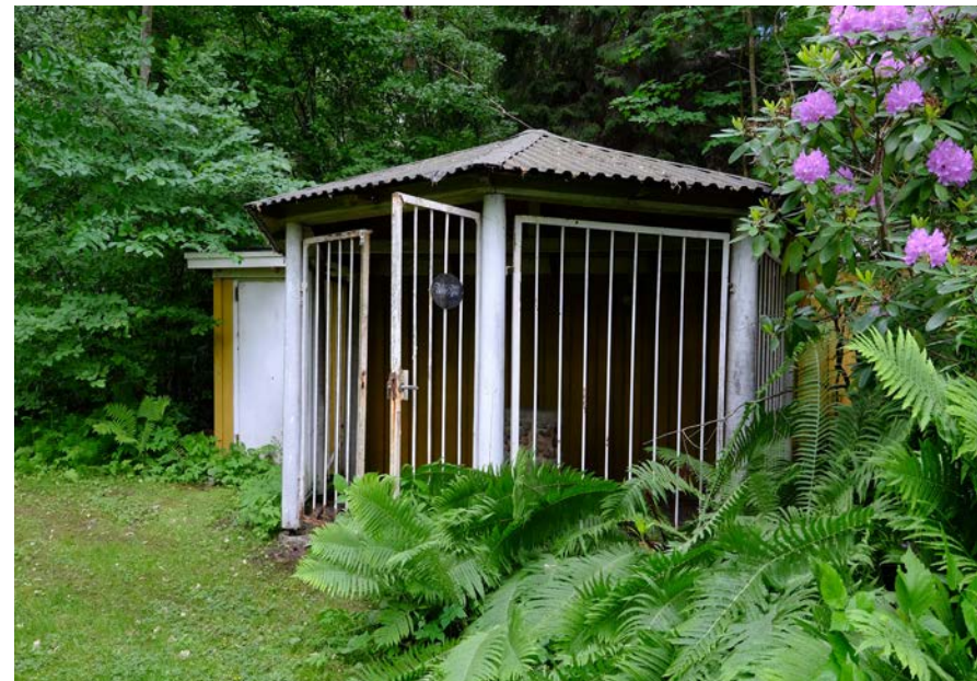
Kioskbyggnaden över källan (U), vy från väster.
