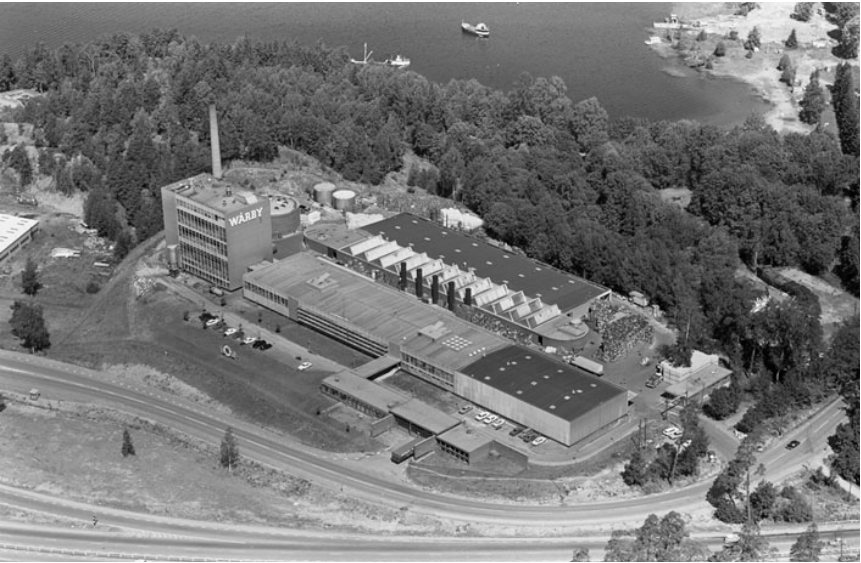
21. Flygfoto, bryggeriet 1969. När denna bild togs hade verkstadsbyggnadens (K) öppna gårdar vid kortsidorna redan byggts igen och centralförrådet (D) uppförts.
