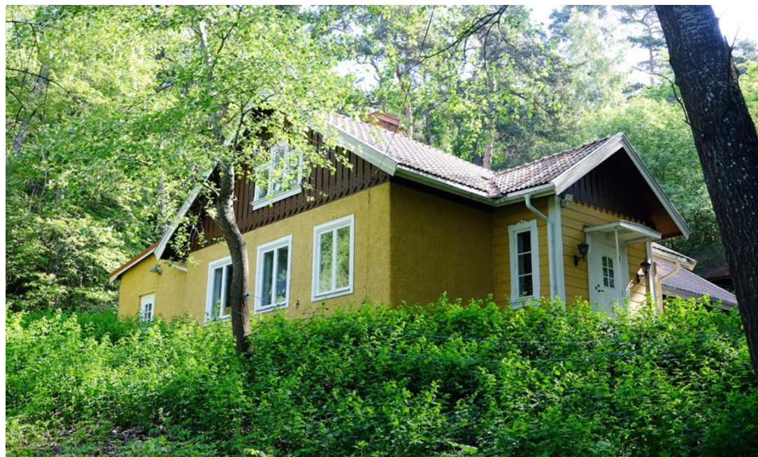
Trädgårdsmästarebostaden (Q). Västra gaveln och södra fasaden.
