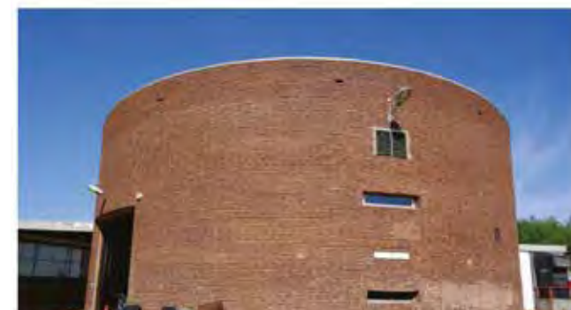
Foto av Panncentralen
