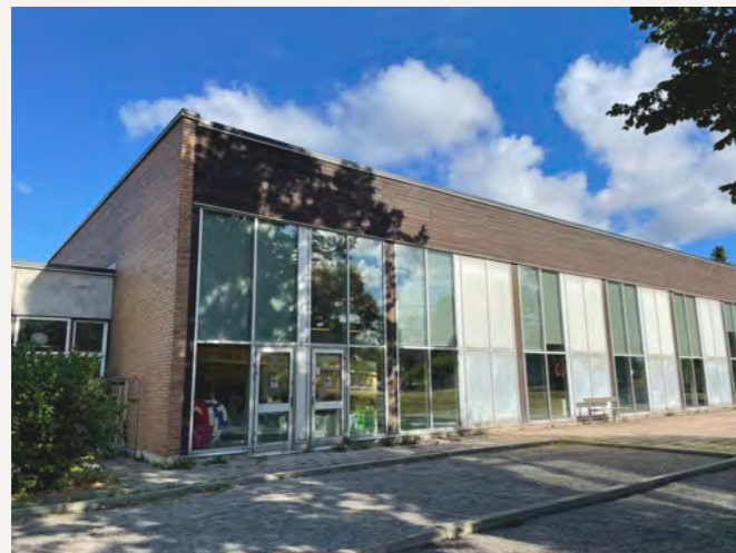
1. Befintlig simhall i tegel, trä och betong.
