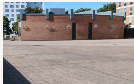
Markmaterial gatssten och betongplattor anknyter till torget vid Huddinge gymnasiums aula (ovan). Mönstret riktas mot hallens huvudentré. Foto: wi landskap
