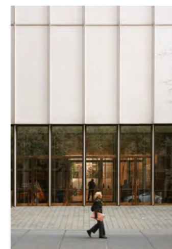
Levande bottenvåning, där byggnadens bottenvåning aktiverar gaturummet.
