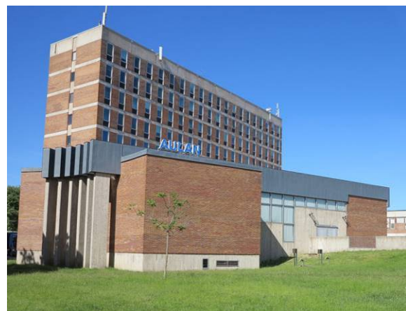
Aulan mot söder. Foto 2020.
