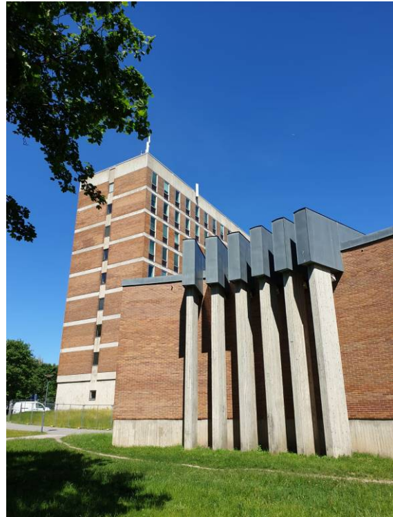
Aulans fasad mot Lännavägen i sydväst. Foto 2020.
