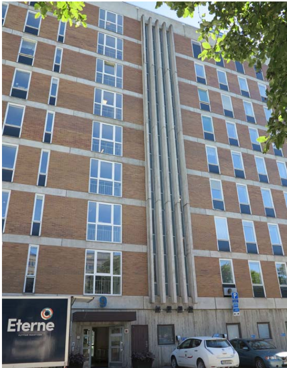
Höghusets fasad nordväst. Foto 2020.
