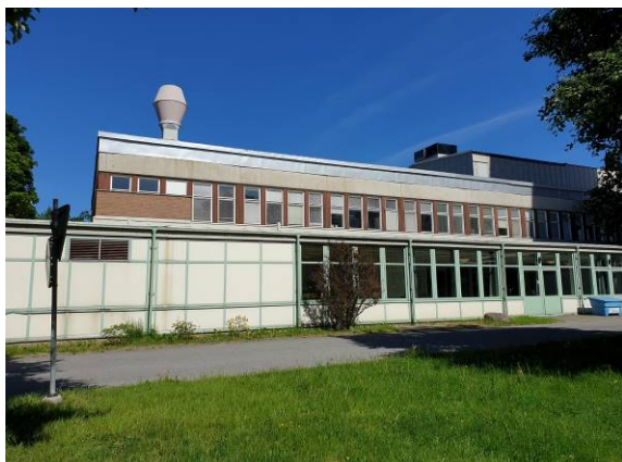
Tillbyggd kök- och matsalsbyggnad vid sydvästfasad.
