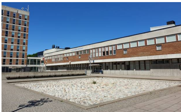
Gymnasiebyggnaden mot torget med länken mot höghuset. Foto 2020.
