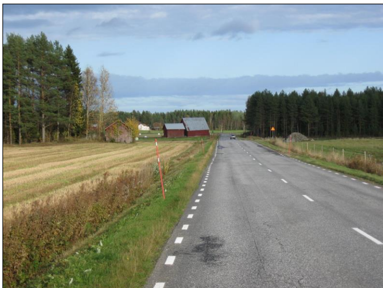
Figur 12. Exempel på vägdike, foto: Trafikverket
