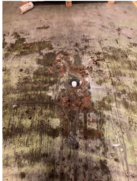
Bild 2. Provpunkt 23W210, grundvattenrör
