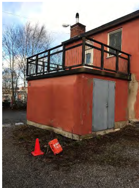
Bild 10. Provpunkt 23W203, vid tidigare oljetank.
