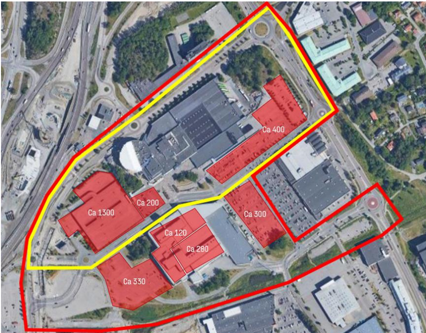
Figur 5. Översikt av befintliga parkeringsytor i Kungens kurva. (Parkeringsytor inom gula rutan fokusområde)
