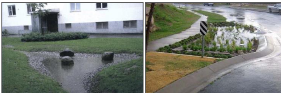
Exempel; Torrdamm, Regngård
