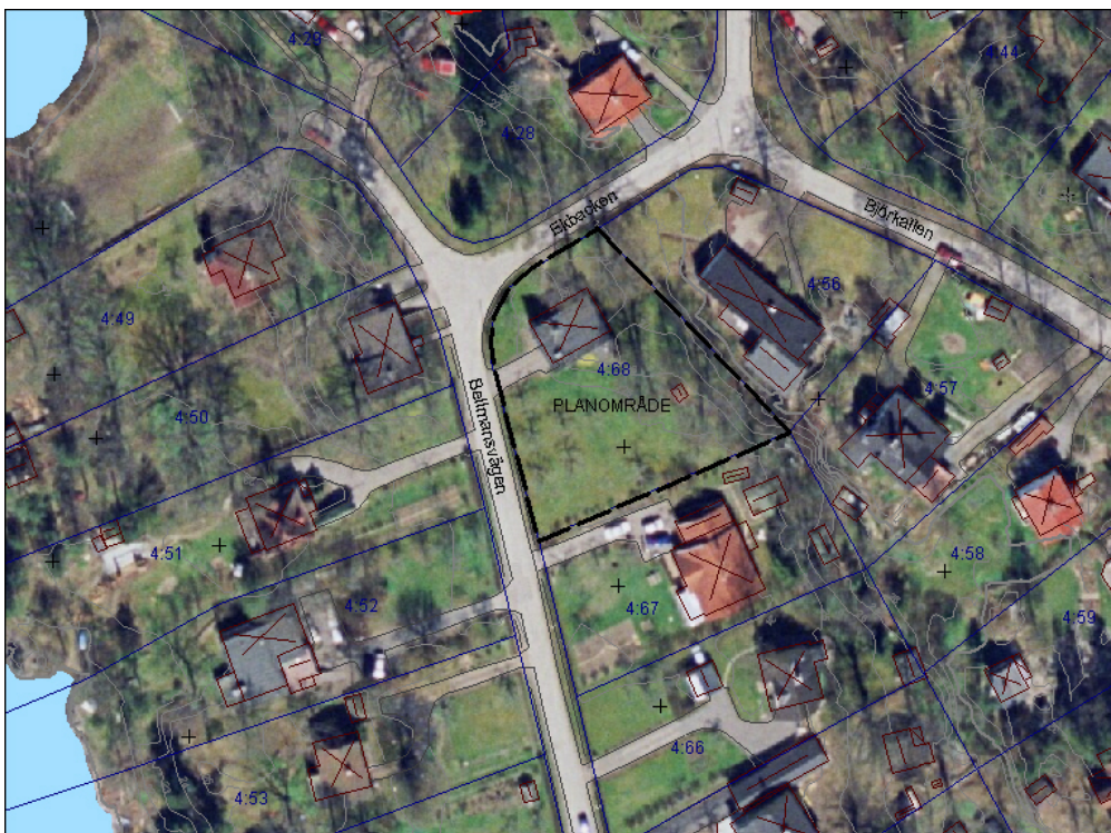
Ortofoto över planområdet samt kringliggande bebyggelse.
