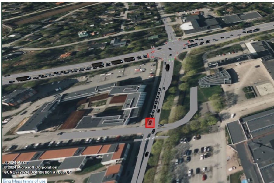
Figur 13: Vänstersvängande fordon på Lännavägen från norr väntar på möjlighet att svänga in mot den nya hallen och hindrar då bakomvarande trafik
